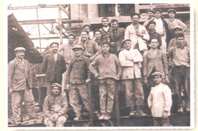
Anni '20. Operai italiani e francesi presso il cantiere per la costruzione della stazione radio di Antibes. Nella fila in alto, al centro, con i baffi e la casacca bianca, Leonello Massetti, emigrato nelle Alpi Marittime col padre Antonio nel 1922; terzo, alla sua destra, il fratello Gino (Foto Angelo Massetti)
