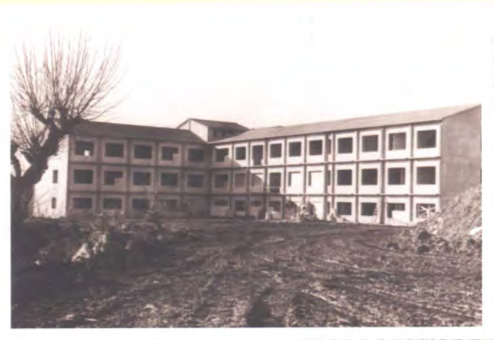
Anno 1972. Costruzione di due nuove ali dell'ospedale di Umbertide (Foto Archivio Fotografico Comunale)
