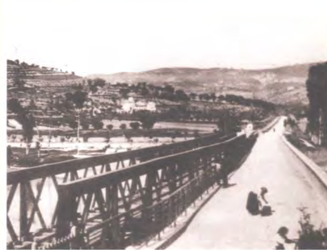
Anno 1906. Il ponte di ferro della ferrovia dell'Appennino poggia sugli stessi piloni della strada per Città di Castello, che sarà asfaltata solo dopo il 1939 (Foto Archivio Fotografico Comunale)
