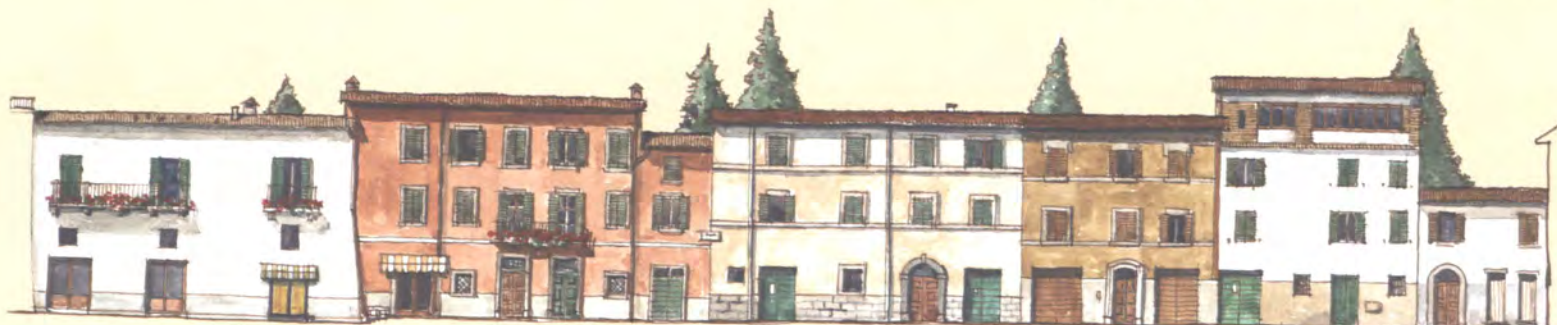
Case in piazza Marconi (lato Ponente). Edifici costruiti dal XVIII al XIX secolo
