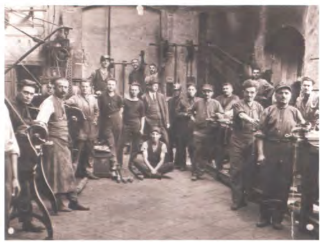
Le prime maestranze dell'Officina - Deposito di Umbertide, riprese nel 1923 all'interno di uno dei capannoni (Collezione G. Severi)
