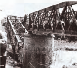
Ponte ferroviario sul Tevere fatto crollare dai tedeschi in ritirata - Foto Roberto Balducci (Riproduz. U. Dominic)
