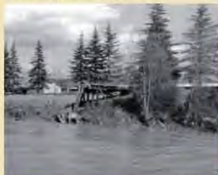
Anno 1977. Il ponte di legno a Montecorona abbattuto dalla piena del Tevere (Foto collezione Giuseppe Severi, Milano)
