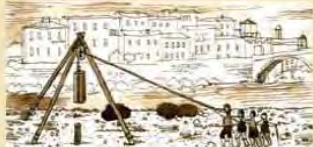
Il rafforzamento delle sponde con l'inserimento di grossi pali
