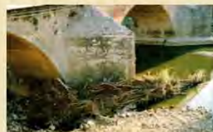
Legna ferma al primo pilone del ponte
