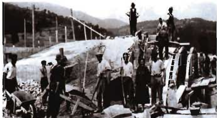
Operai al lavoro per la costruzione del ponte ferroviario a Montecorona.
