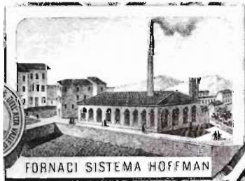
Marchio della fornace di laterizi situata nella zona di Santa Maria.
