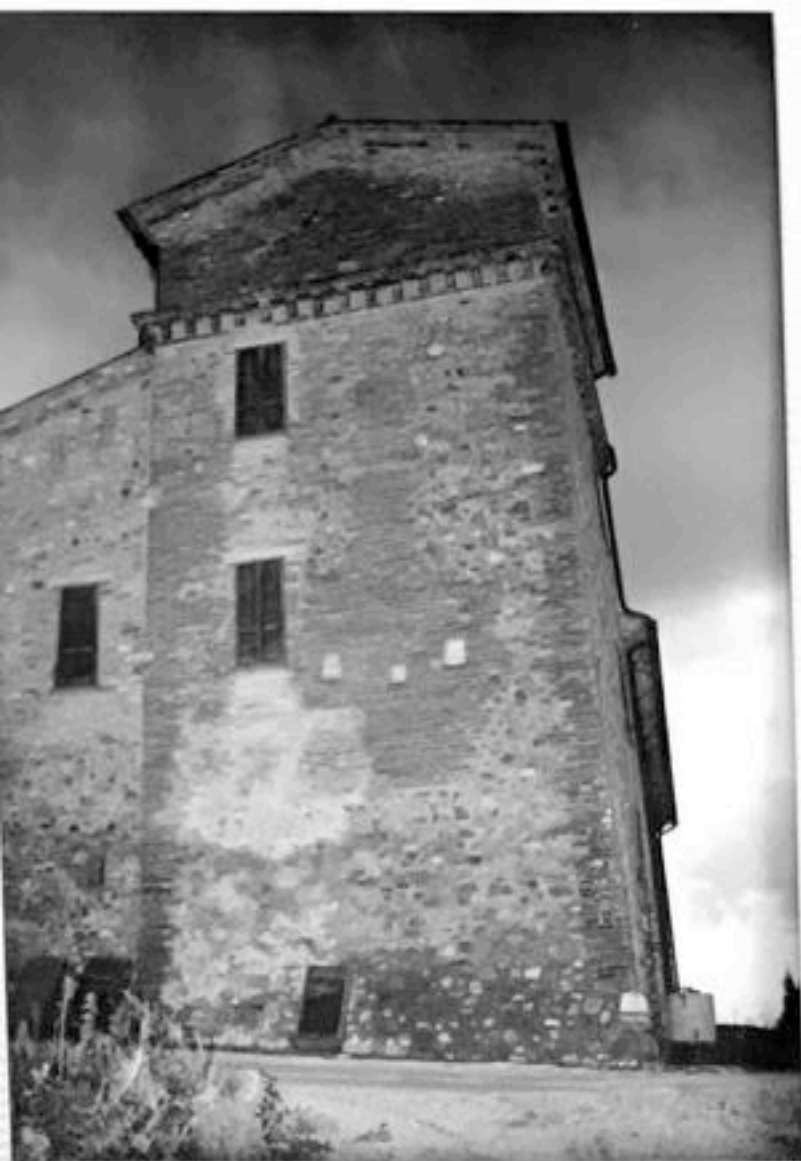
FOTO n°48 VOC.CENERELLE veduta della torre, lato nord
