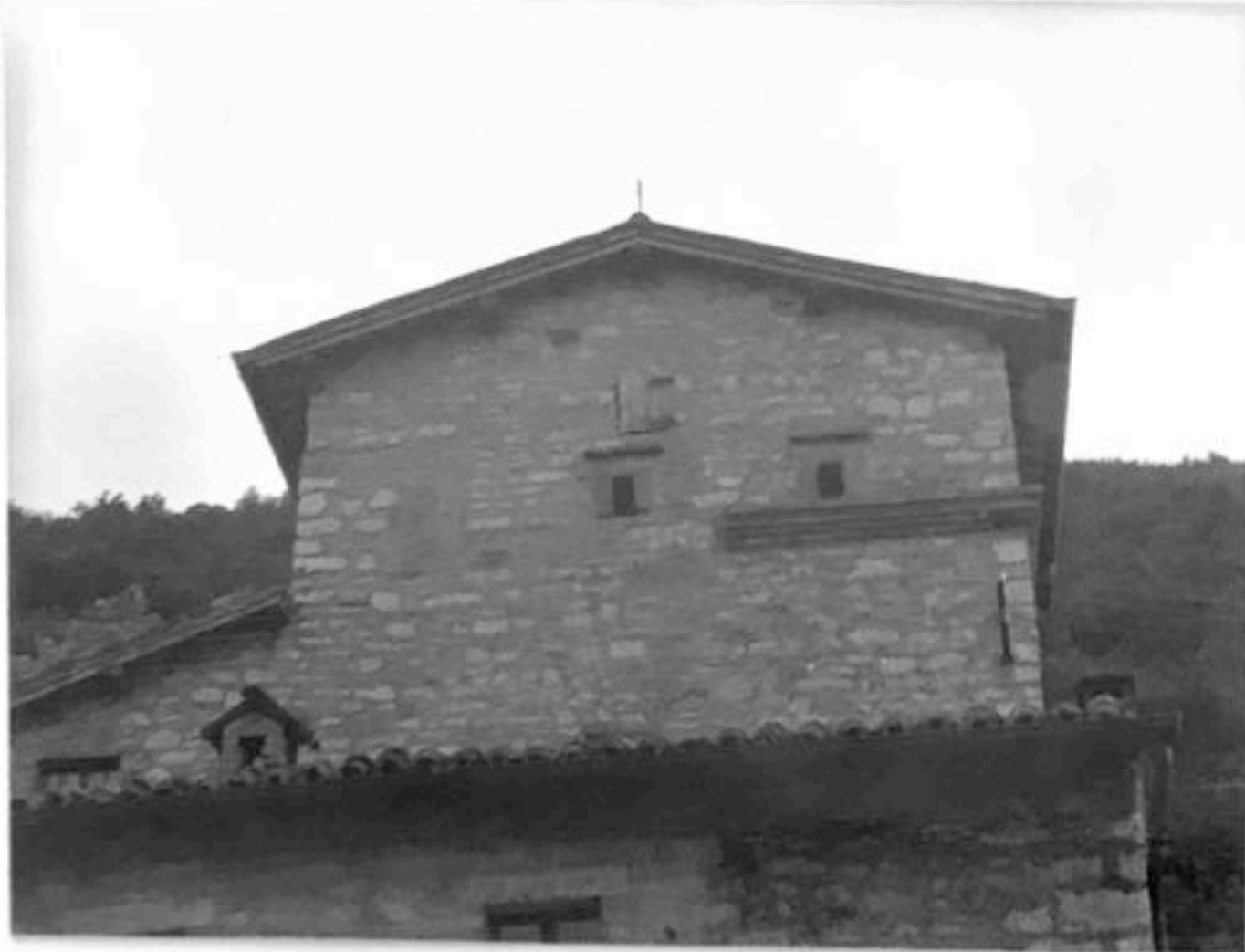
FOTO n°53 particolare della torre
