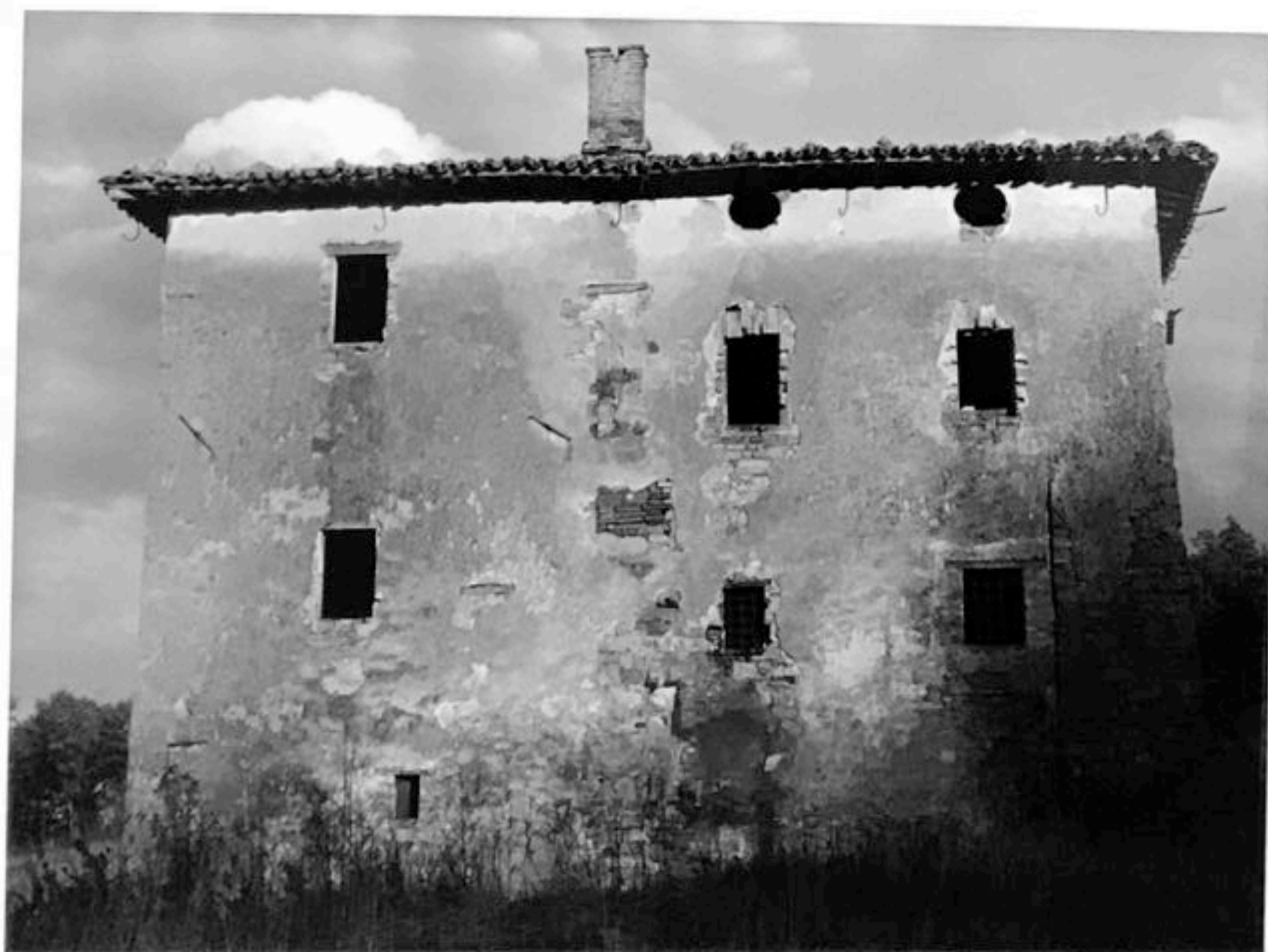
FOTO n°96 veduta lato est
