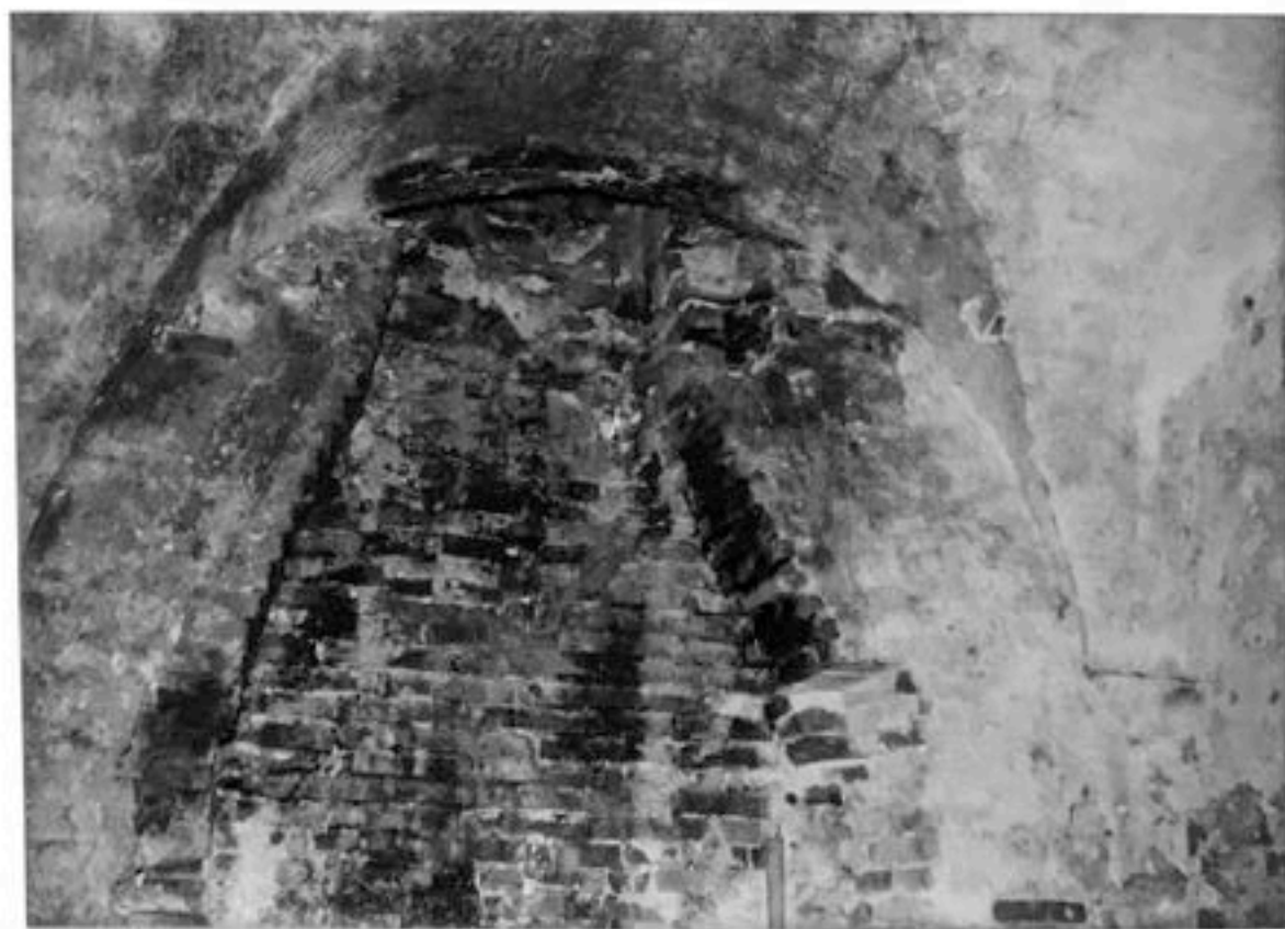
FOTO n°36 interno della torre, primo piano del camino
