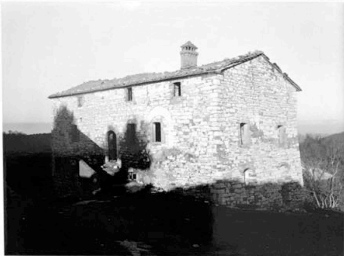
FOTO n°27 casa colonica nelle vicinanze della torre
