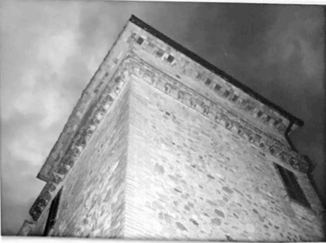
FOTO n°47 VOC.CENERELLE particolare della torre
