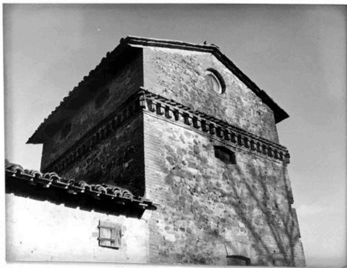
FOTO n°34 particolare del cordolo
