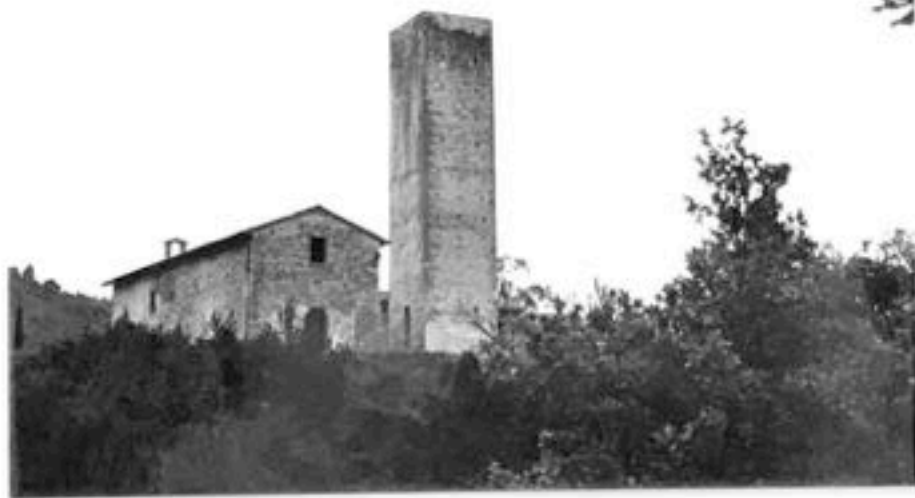
FOTO n°2 SANTA GIULIANA torre di guardia e canonica
