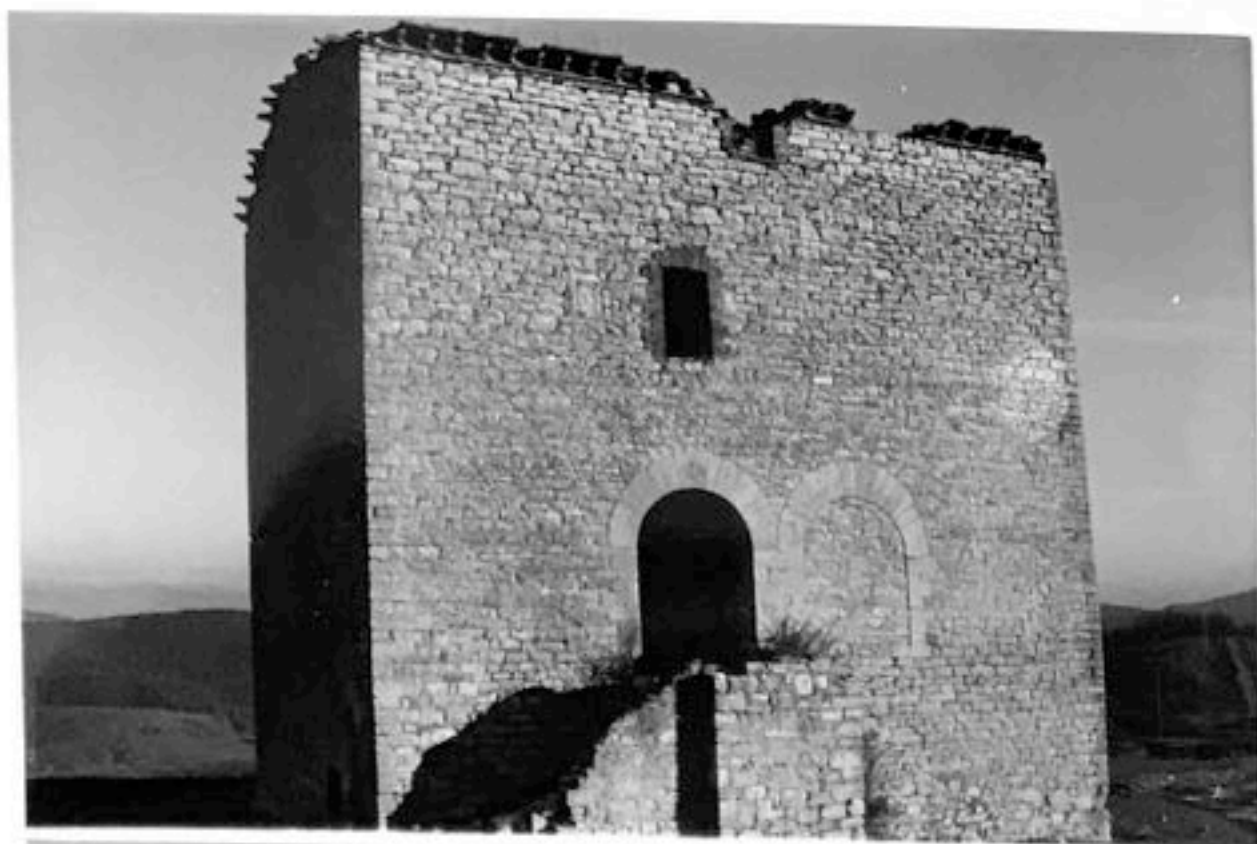
FOTO n°22 VOC.GALERA la torre ingresso lato ovest
