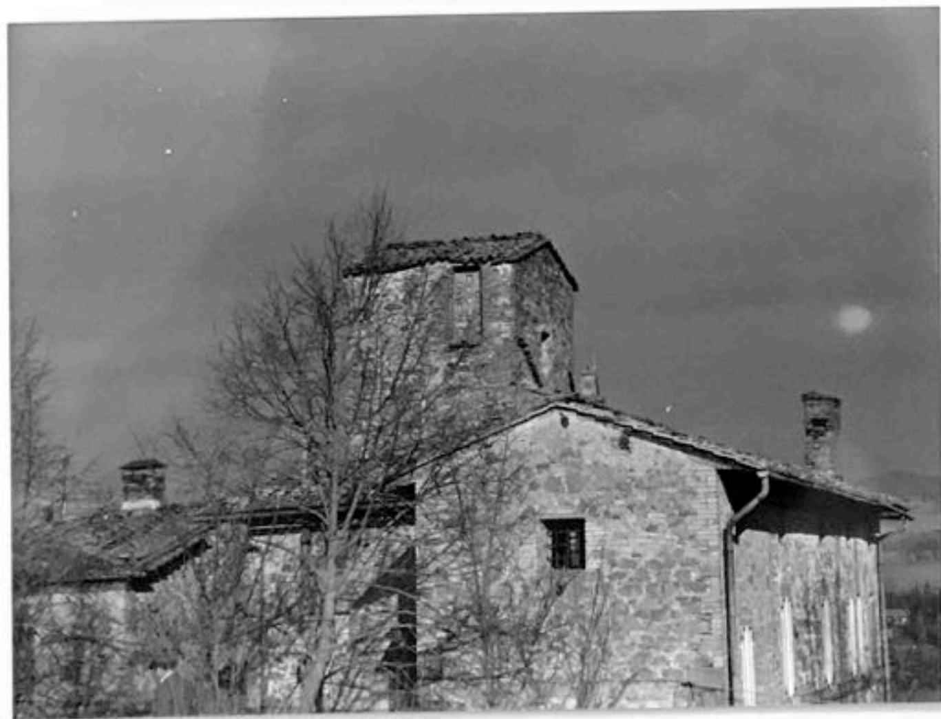
FOTO n°42 particolare della torre
