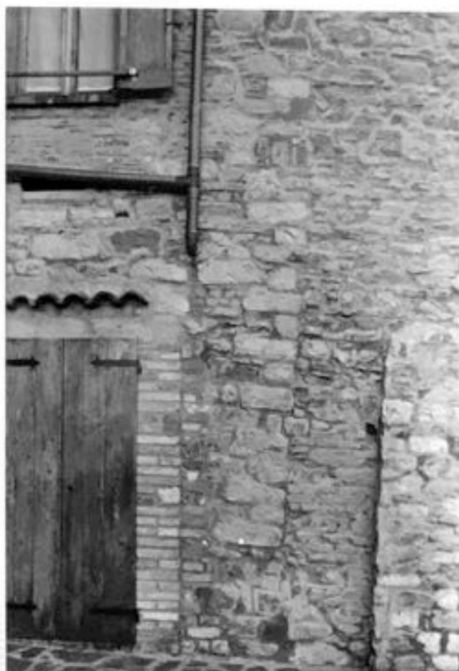
FOTO n°80 particolare del contrafforte che delimitava l'antica struttura
