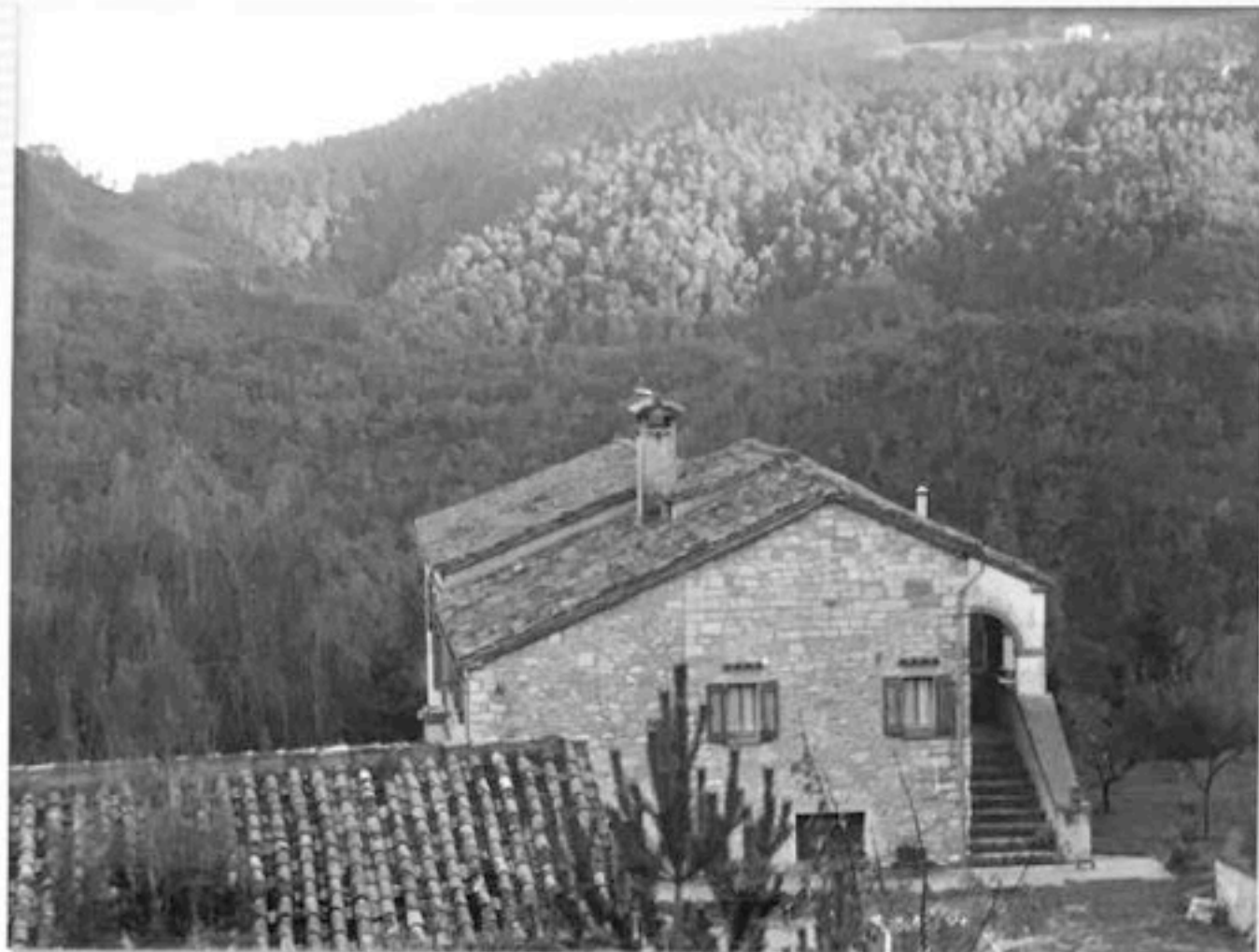
FOTO n°75 veduta dall'alto del lato ovest
