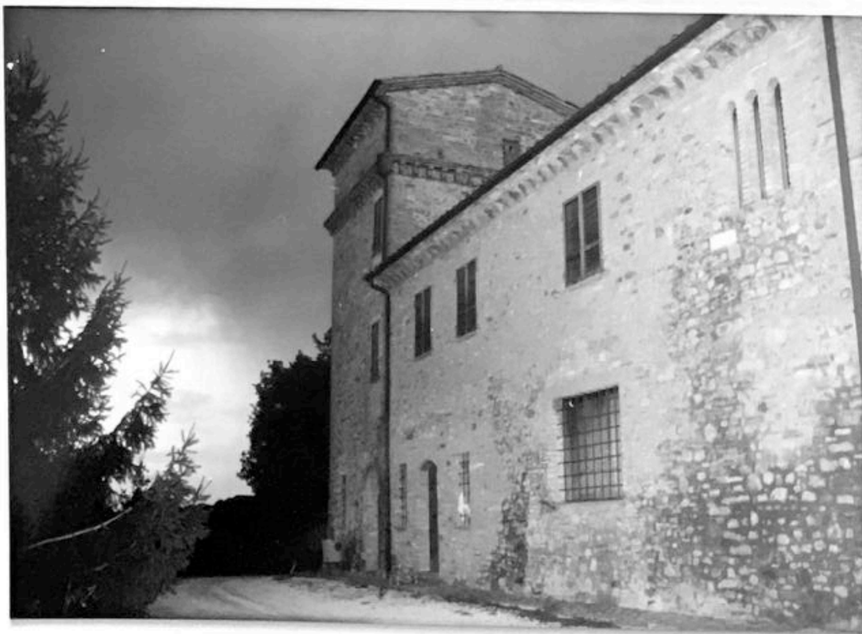
FOTO n°50 veduta del lato ovest
