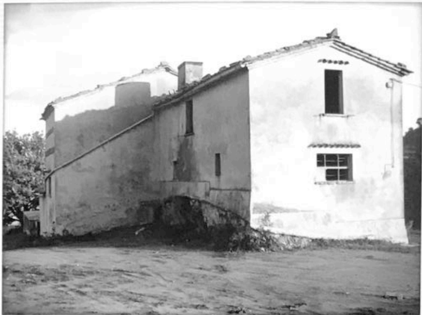
FOTO n°85 veduta del lato sud-ovest
