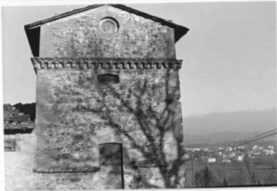
FOTO n°31 loc.Romeggio,ingresso al secondo piano
