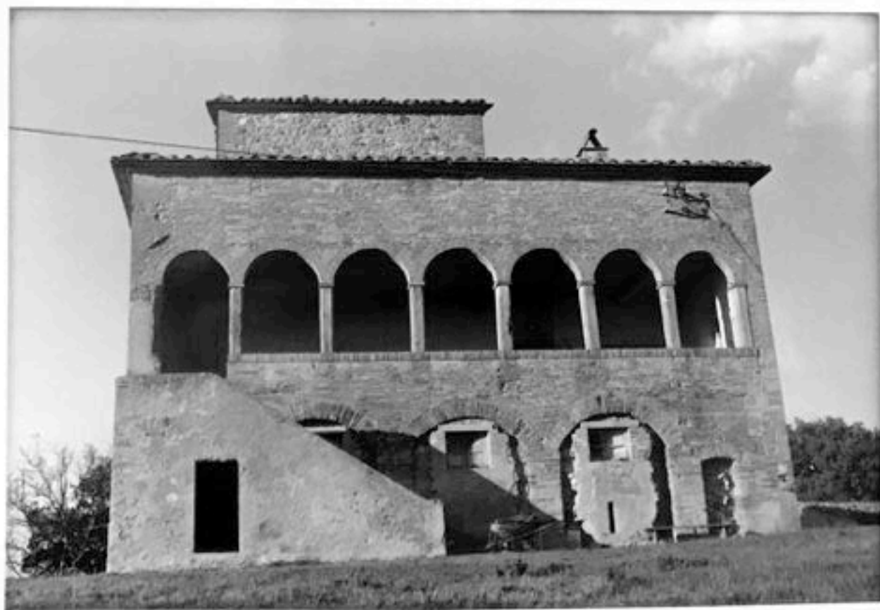
FOTO n°70 VOC.COL DI POZZO facciata d'ingresso
