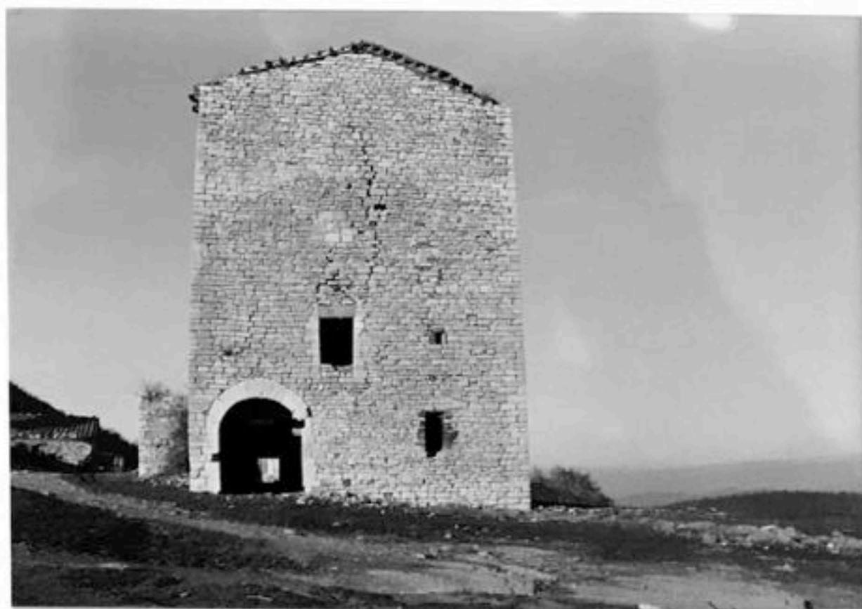
FOTO n°24 VOC.GALERA lato sud
