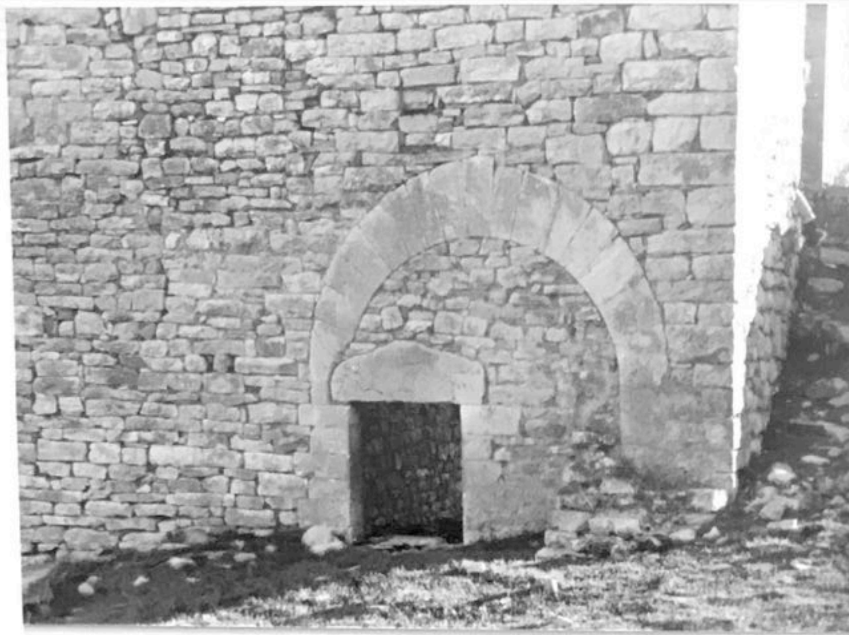
FOTO n°25 VOC.GALERA lato nord particolare
