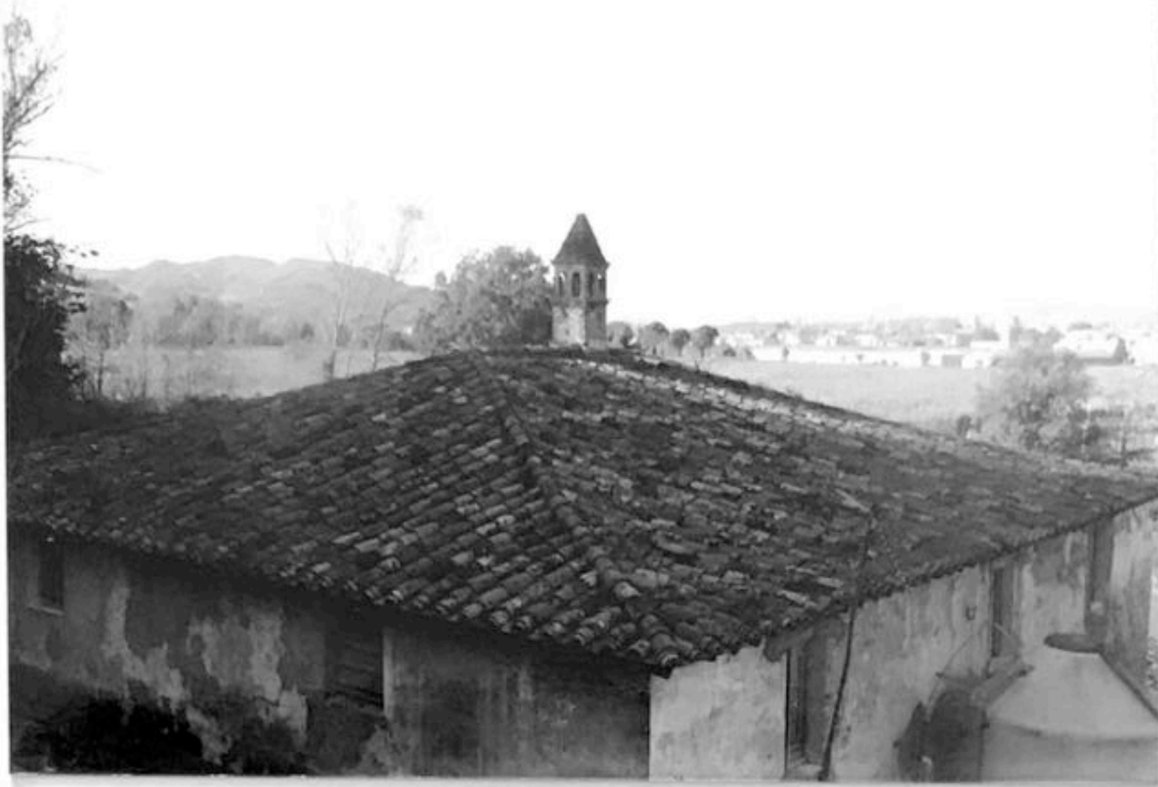
FOTO n° 87 VOC. MOLINO DI CASANOVA particolare del tetto
