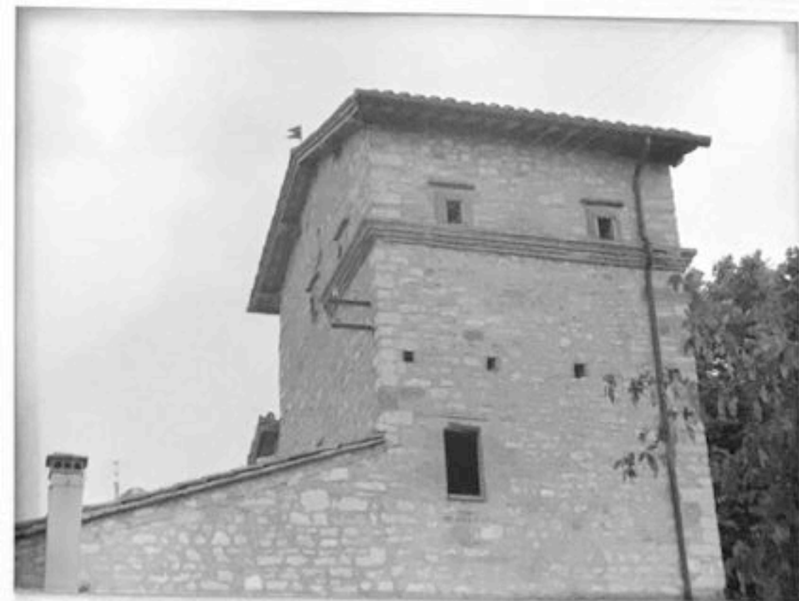
FOTO n°56 particolare della torre
