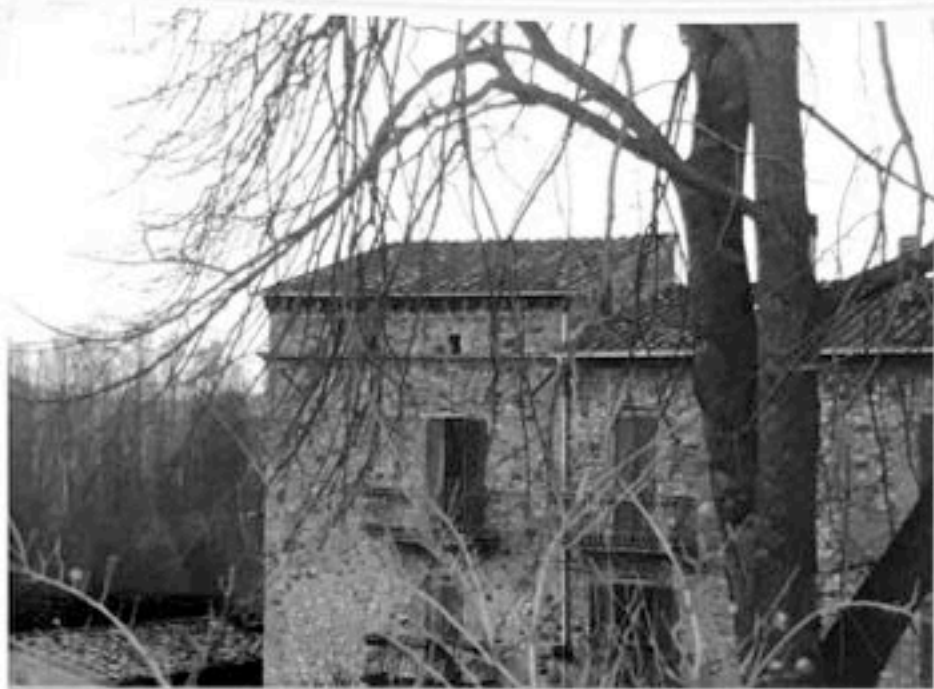
FOTO n°67 particolare della torre
