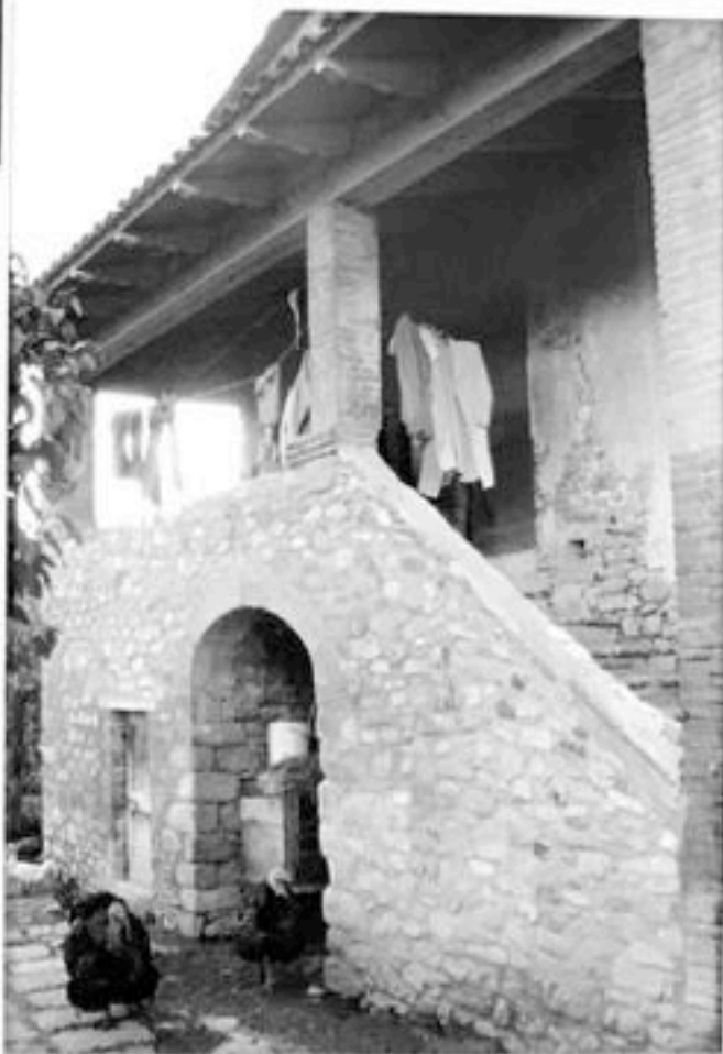
FOTO n°64 ingresso nel versante interno del cortile
