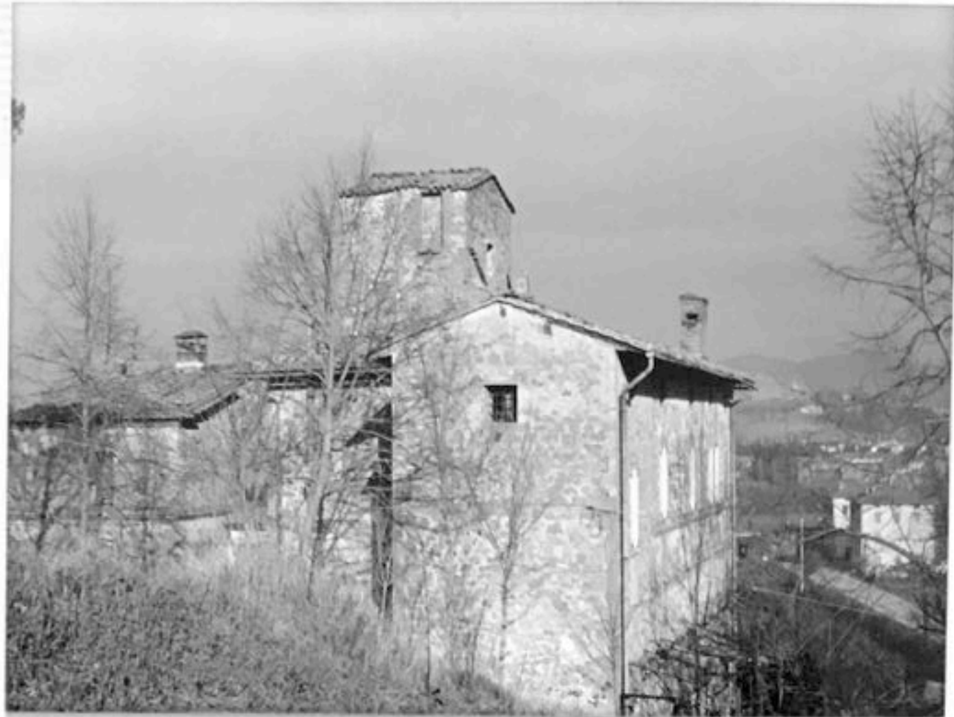
FOTO n°41 VOC.PIAGGIA DI METOLA veduta posteriore della torre
