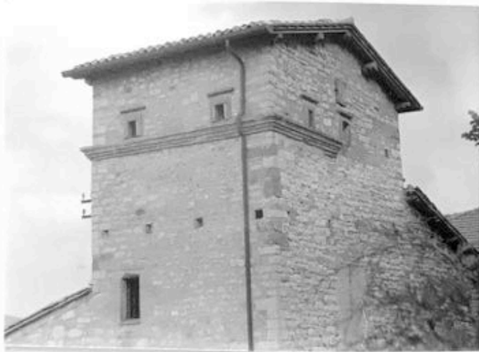
FOTO n°52 VOC.OSTERIA veduta lati ovest e nord
