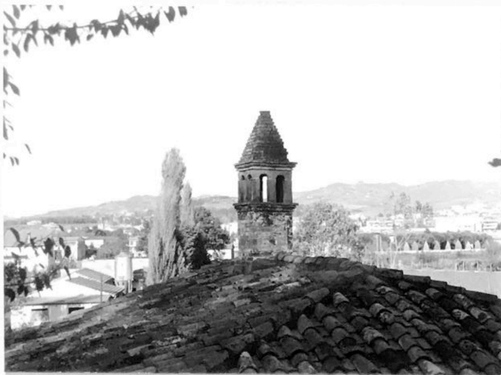
FOTO n°88 particolare del comignolo
