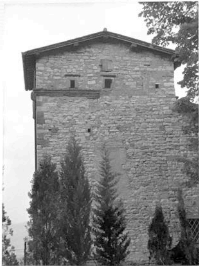
FOTO n°57 lato ovest della torre
