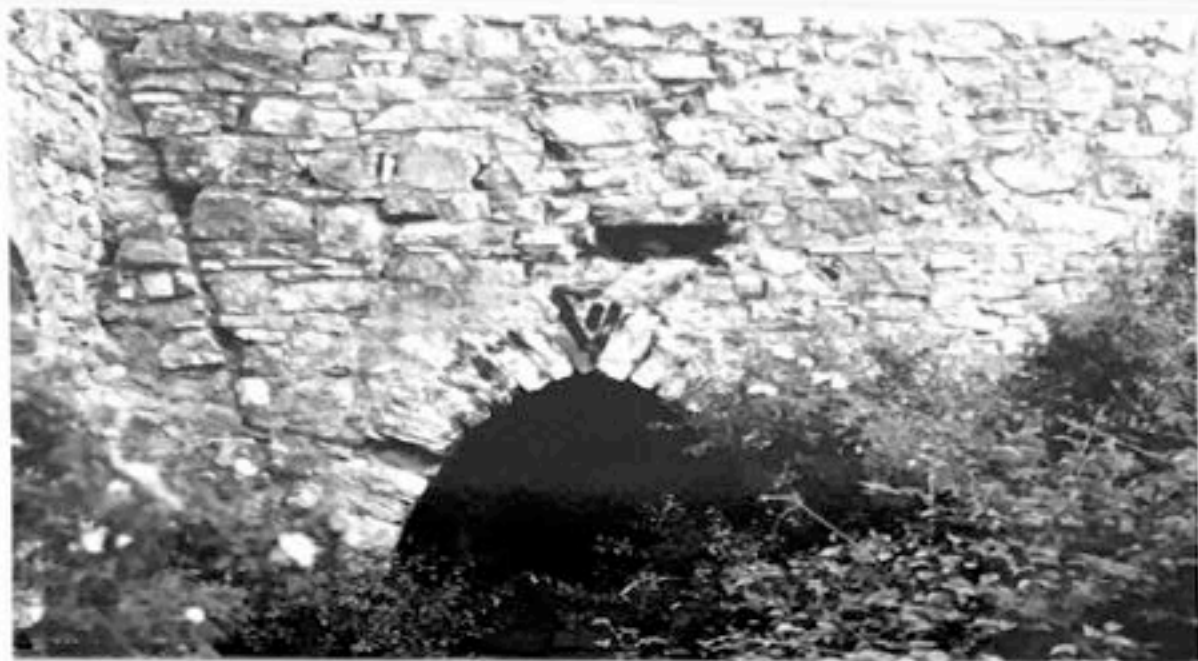
FOTO n°9 particolare del forno
