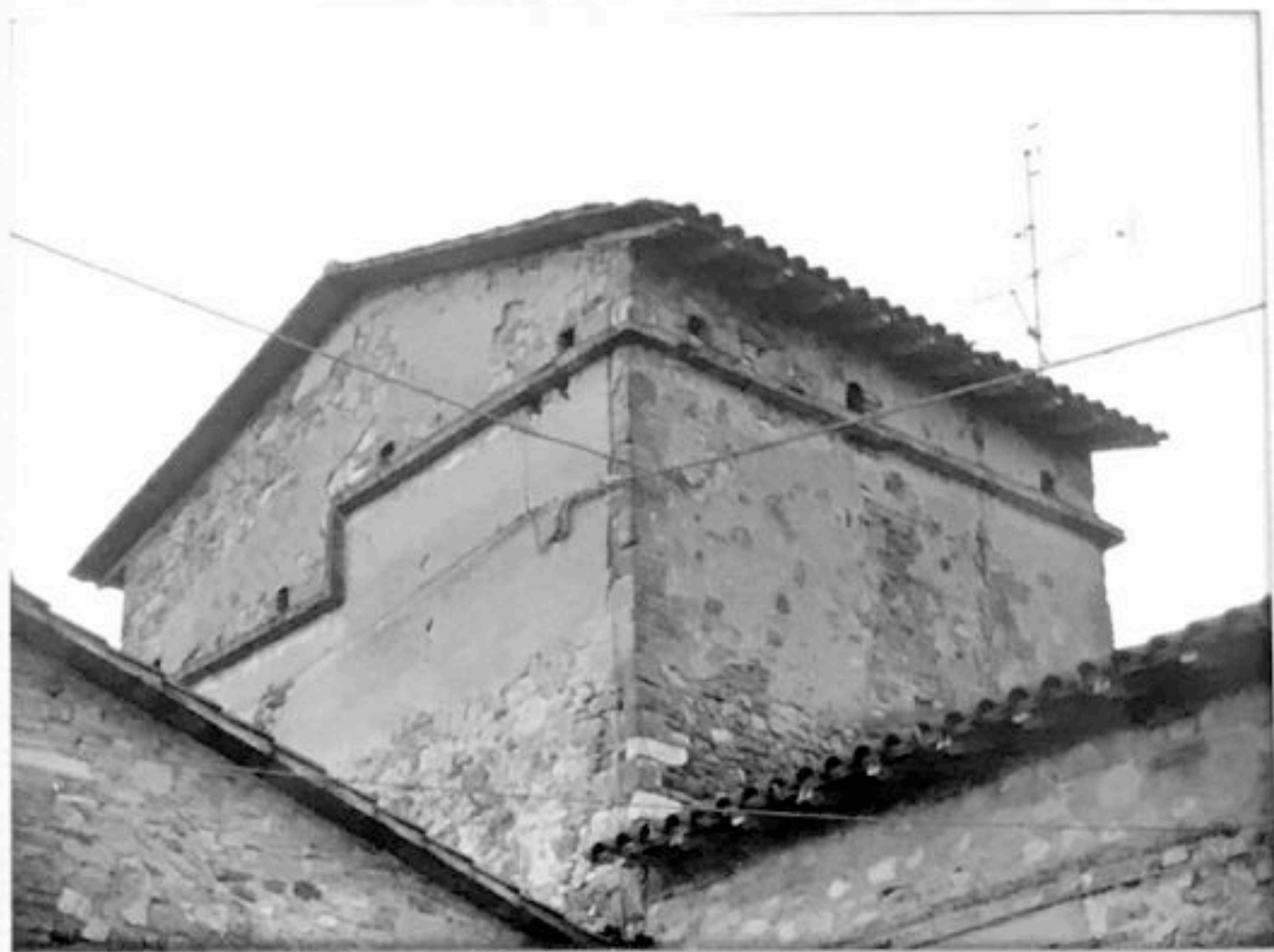
FOTO n°62 particolare della torre
