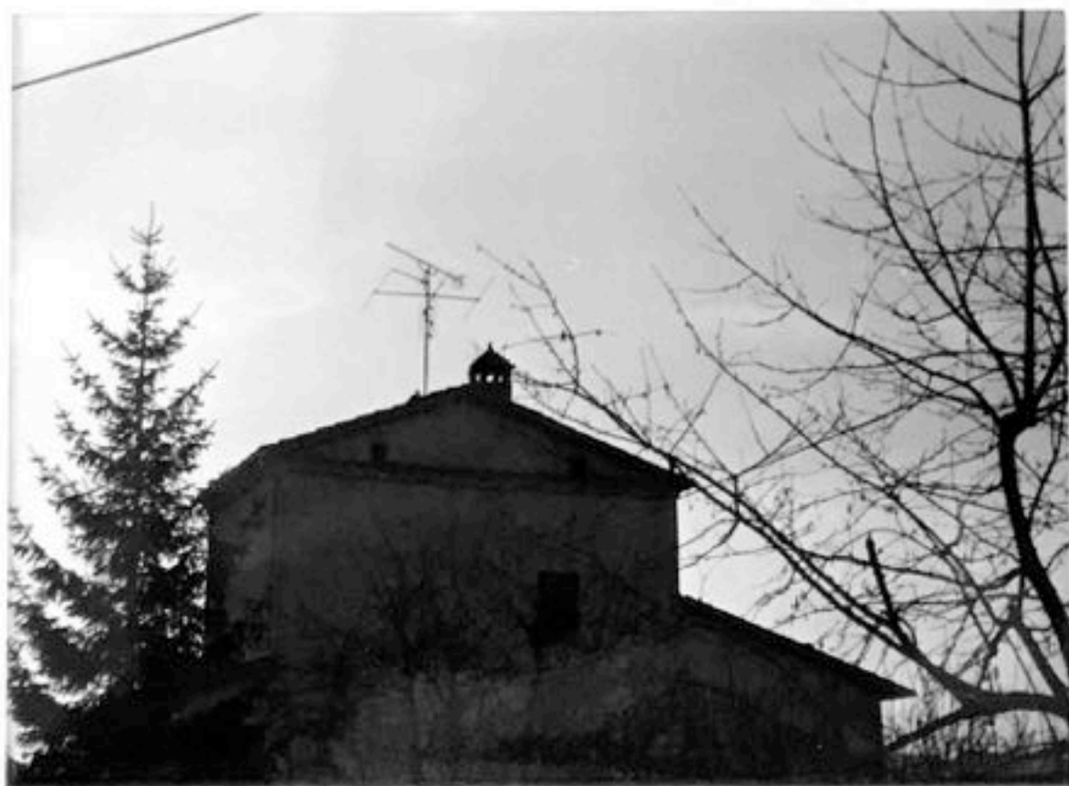
FOTO n°58 particolare della torre
