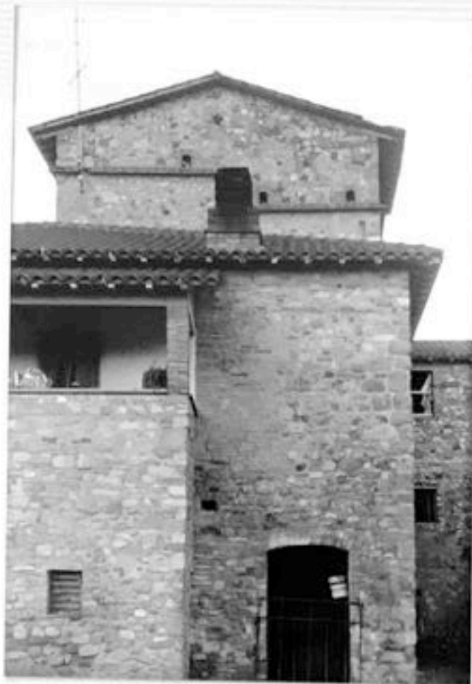
FOTO n°63 lato ovest della casa
