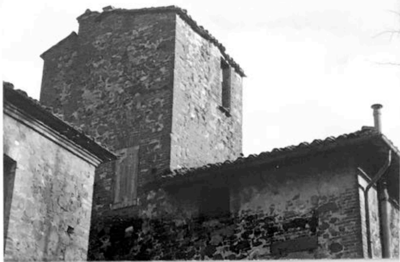
FOTO n°45 particolare della torre lati nord e ovest
