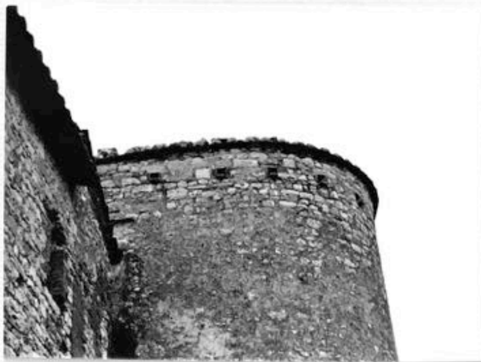
FOTO n°8 particolare della torre
