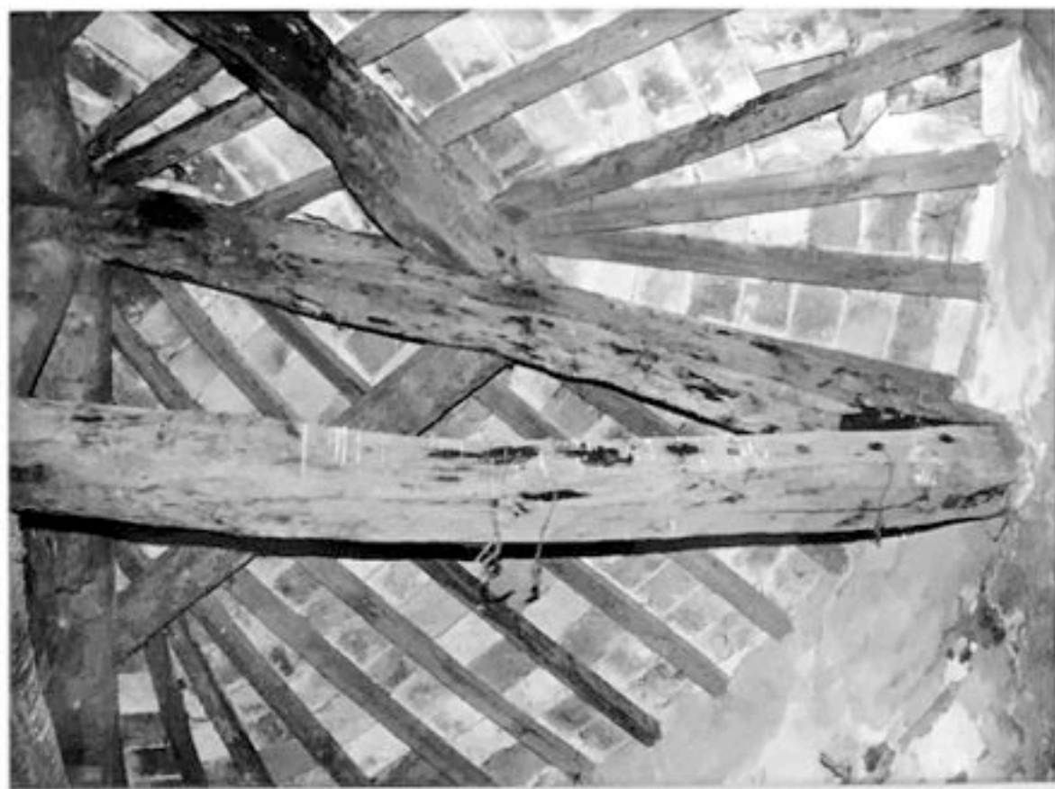
FOTO n°20 soffitto della torre
