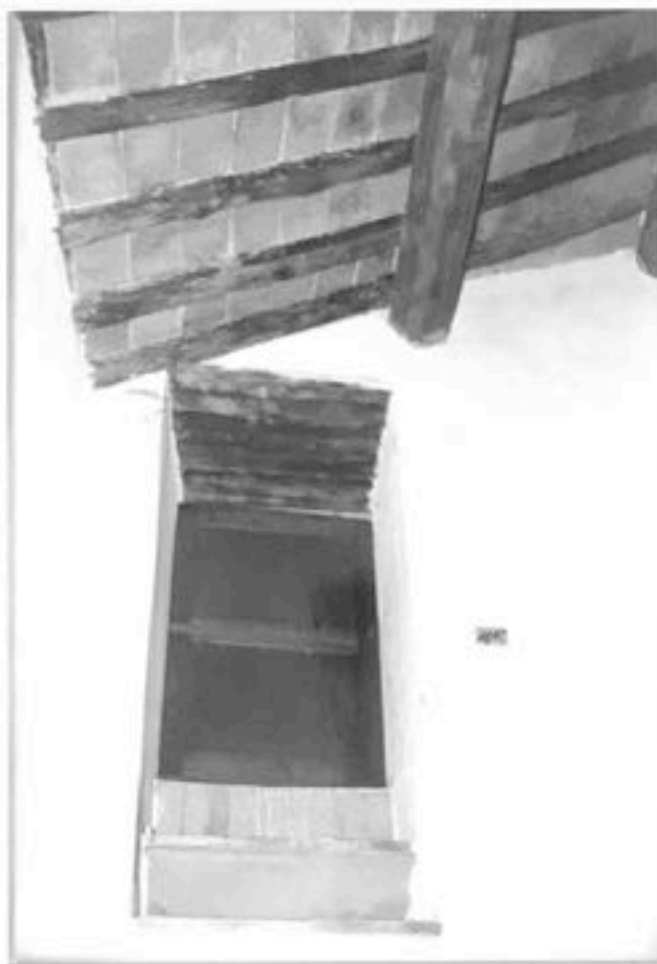
FOTO n°79 porta che conduce al sotto- tetto
