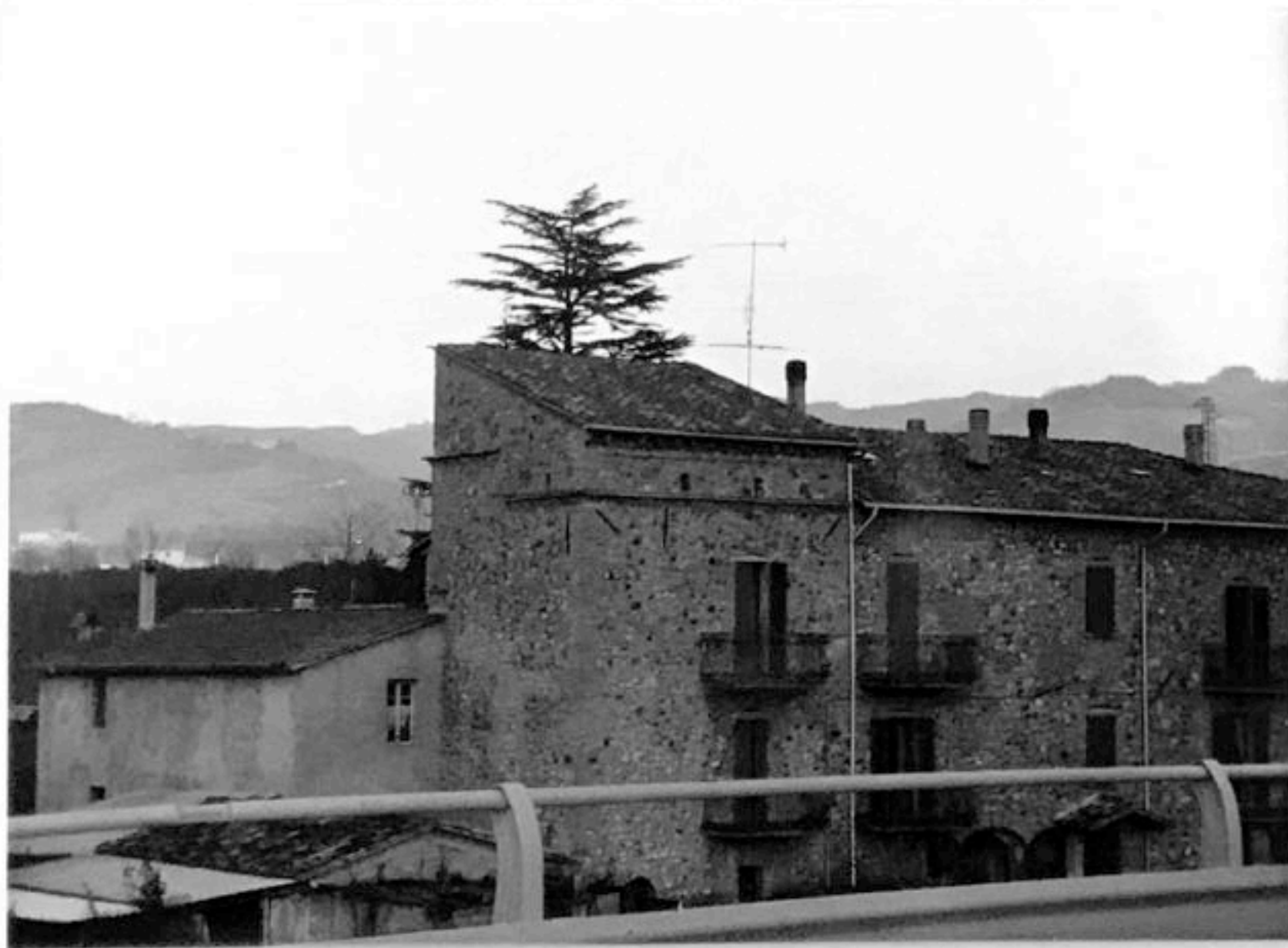
FOTO n°66 veduta della torre e della casa
