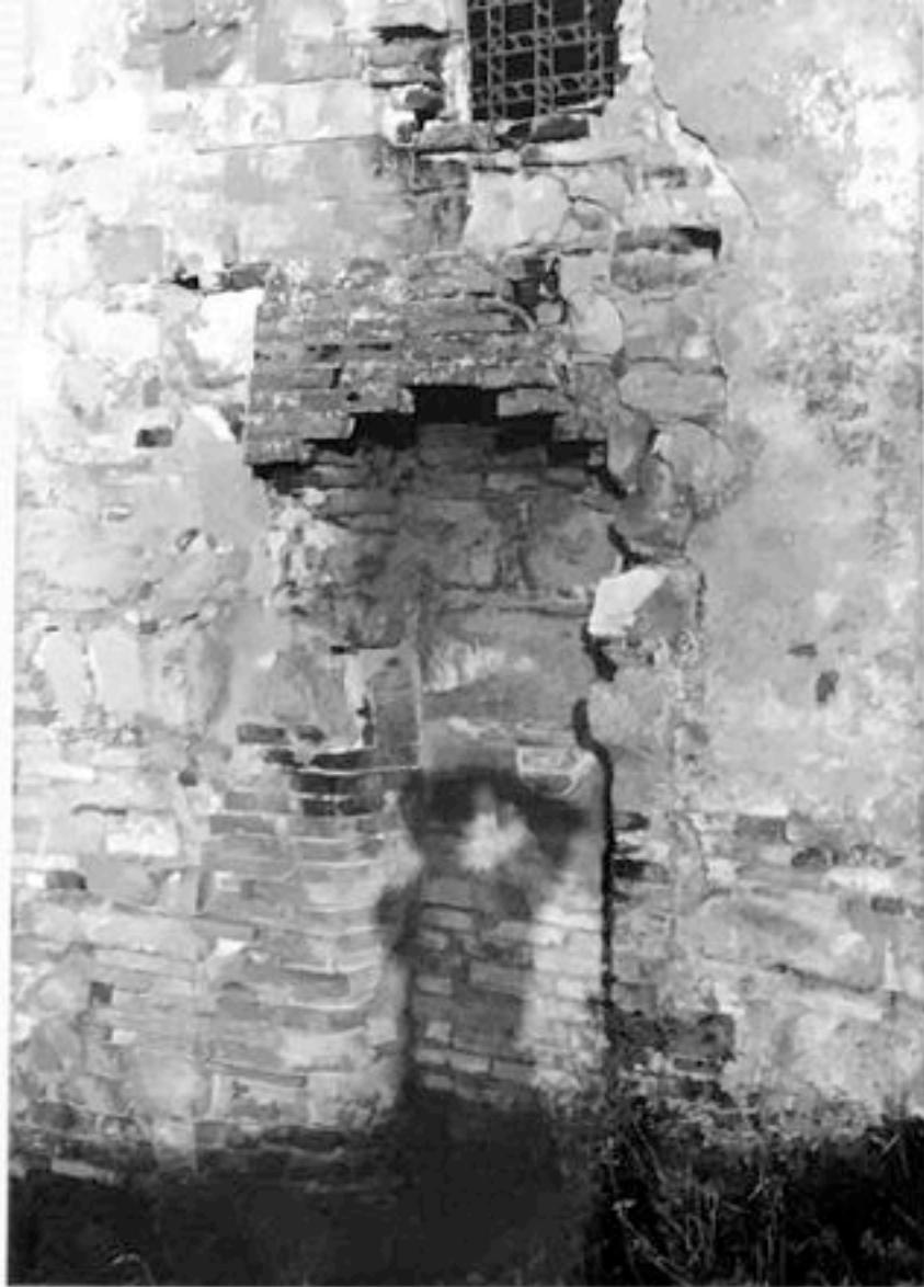
FOTO n°97 particolare del forno
