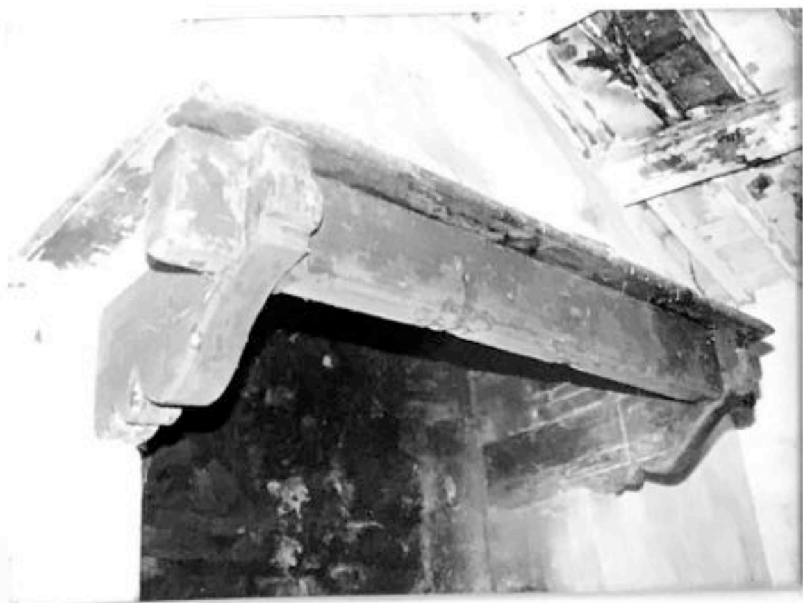
FOTO n°18 particolare del camino
