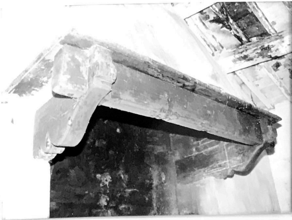
FOTO n°18 particolare del camino
