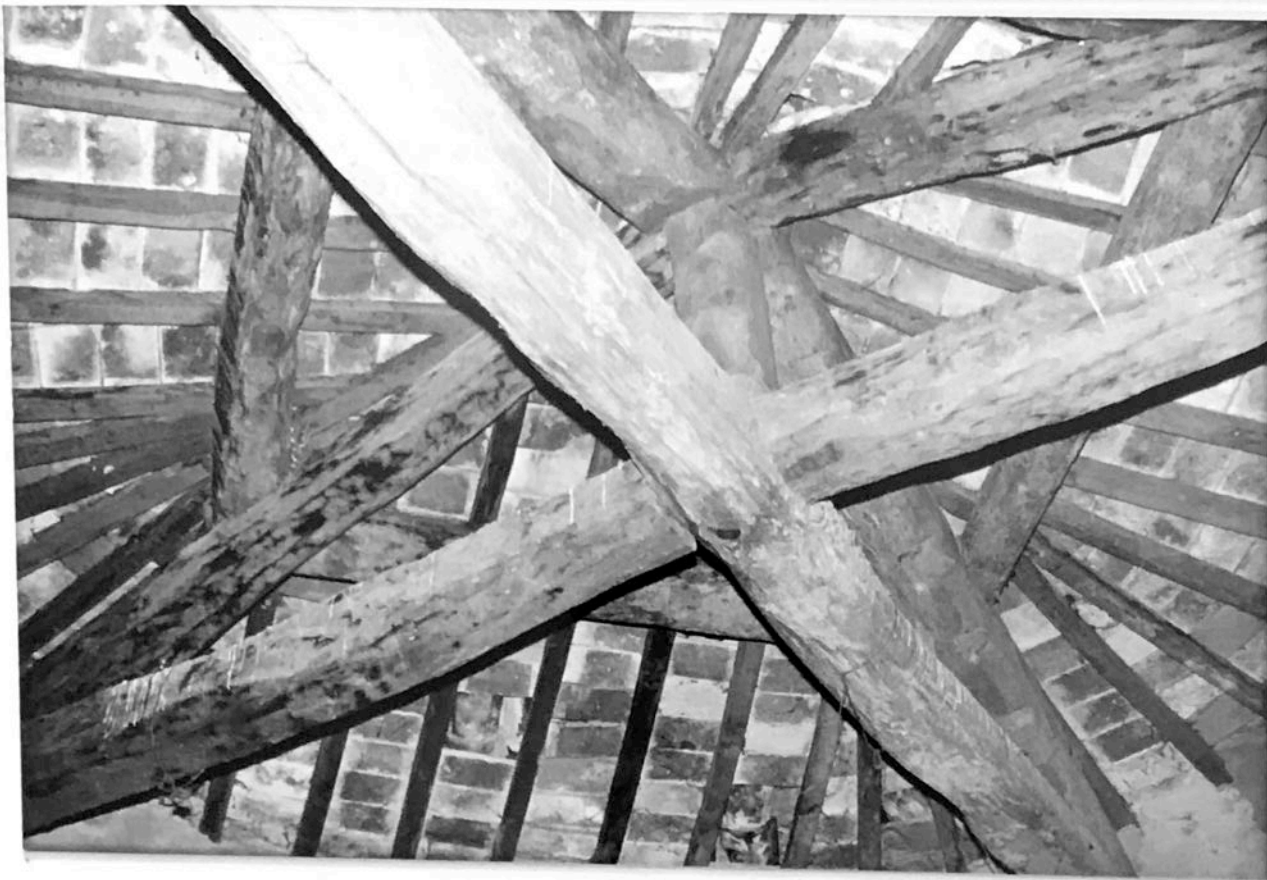
FOTO n°21 particolare del soffitto della torre
