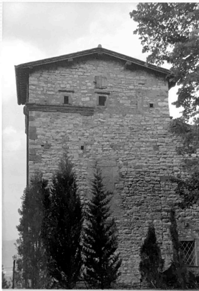
FOTO n°51 VOC.OSTERIA veduta del lato ovest della torre
