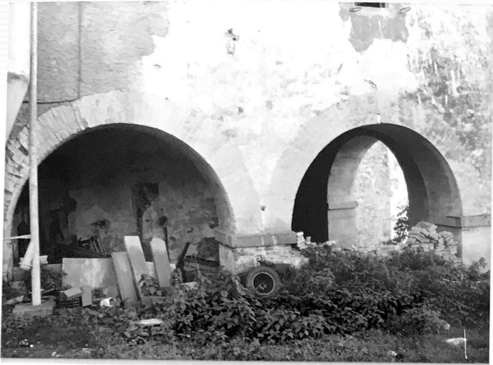
FOTO n°89 particolare del loggiato al piano terreno
