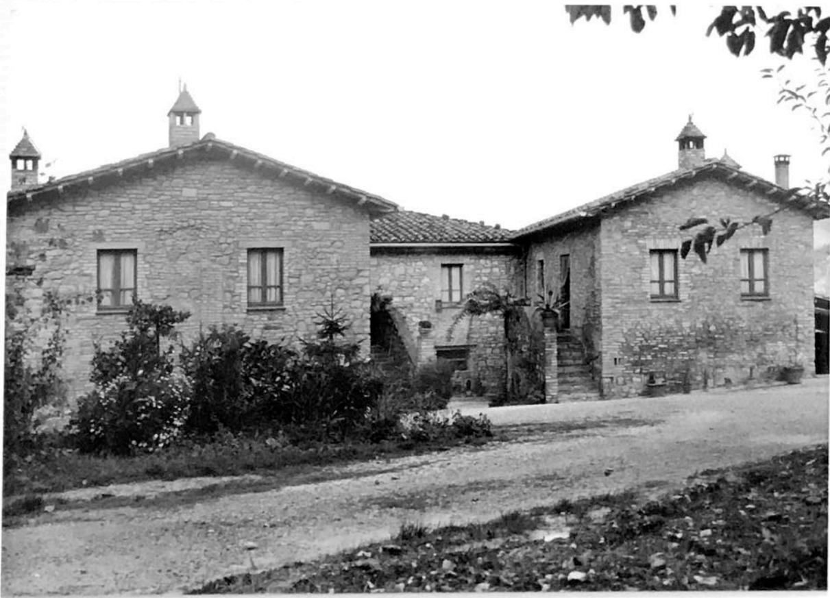
FOTO n°104 VOC. LA FORNACE ingresso alle abitazioni
