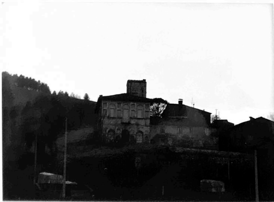
FOTO n°40 VOC.PIAGGIA DI METOLA veduta del complesso
