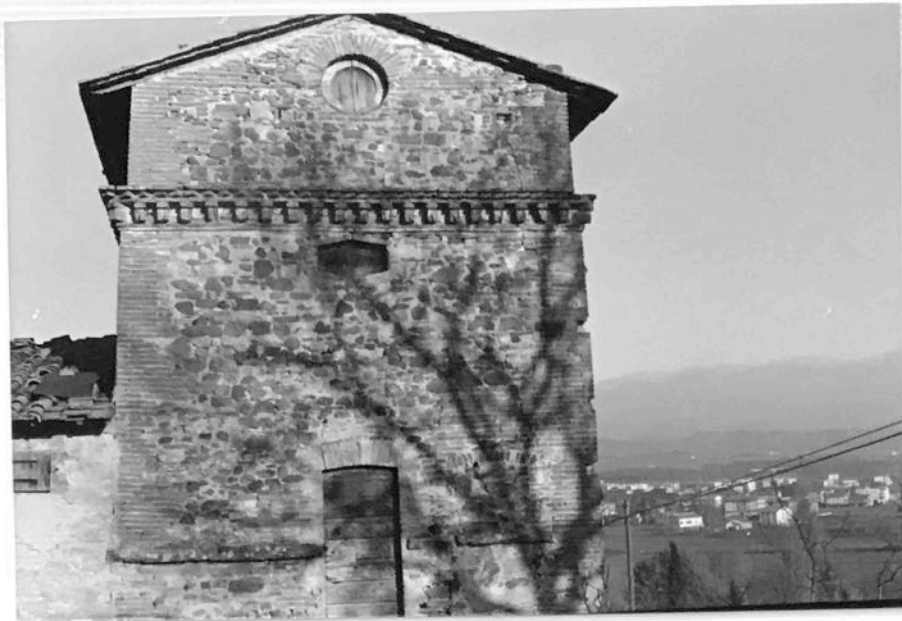
FOTO n°31 loc.Romeggio, ingresso al secondo piano
