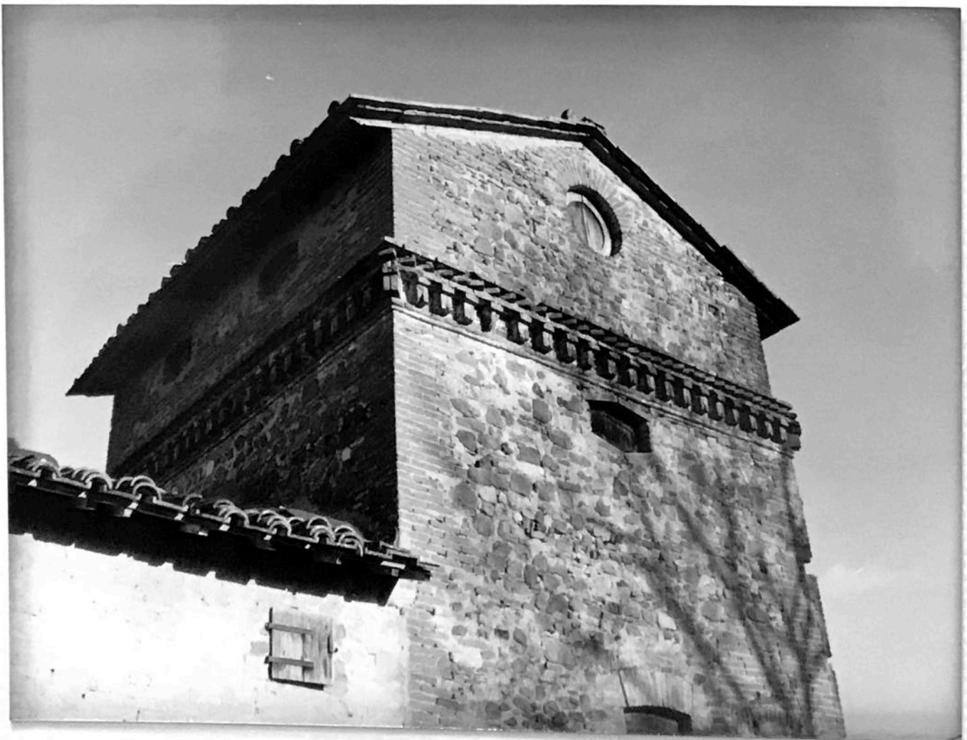
FOTO n°34 particolare del cordolo
