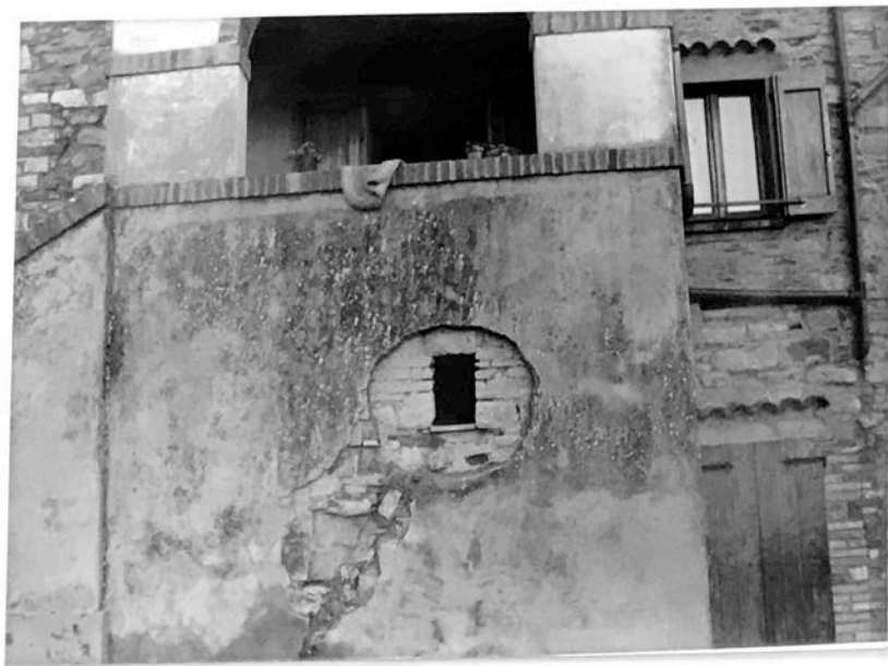
FOTO n°74 particolare di una vecchia apertura nella scala d'ingresso
