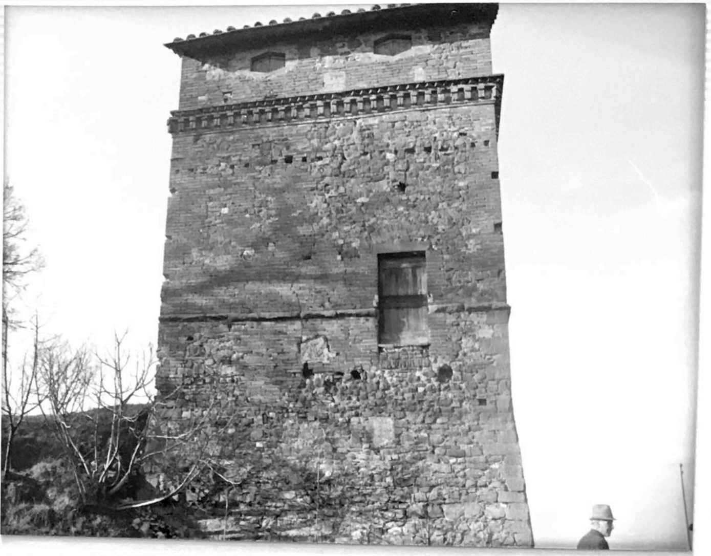
FOTO n°33 lato sud della torre
