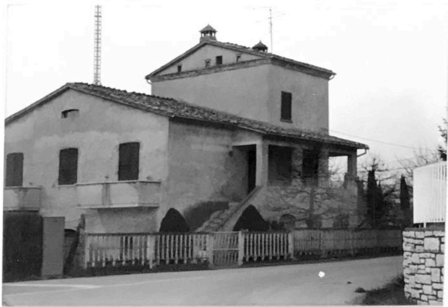
FOTO n°60 veduta d'insieme della casa con la facciata d'ingresso
