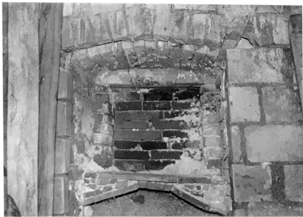
FOTO n°72 particolare del piccolo arco di sinistra
