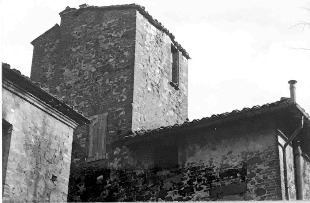
FOTO n°45 particolare della torre lati nord e ovest
