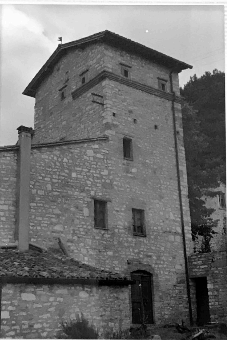
FOTO n°55 veduta della torre dal basso
