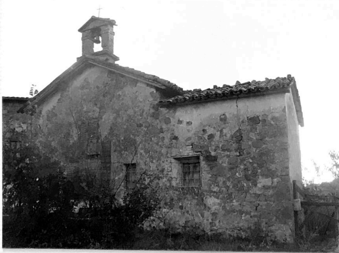
FOTO n°100 chiesa del borgo
