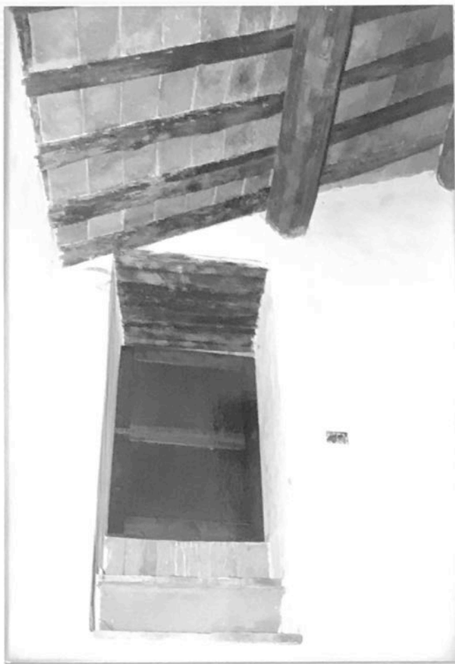
FOTO n°79 porta che conduce al sottotetto
