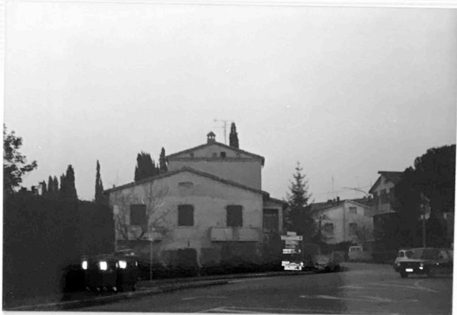
FOTO n°59 lato ovest della casa e della torre
