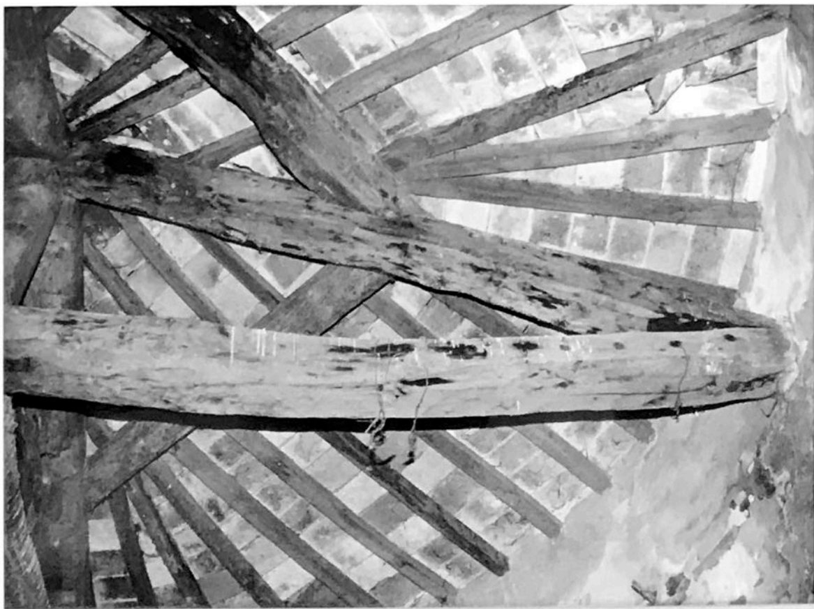
FOTO n°20 soffitto della torre
