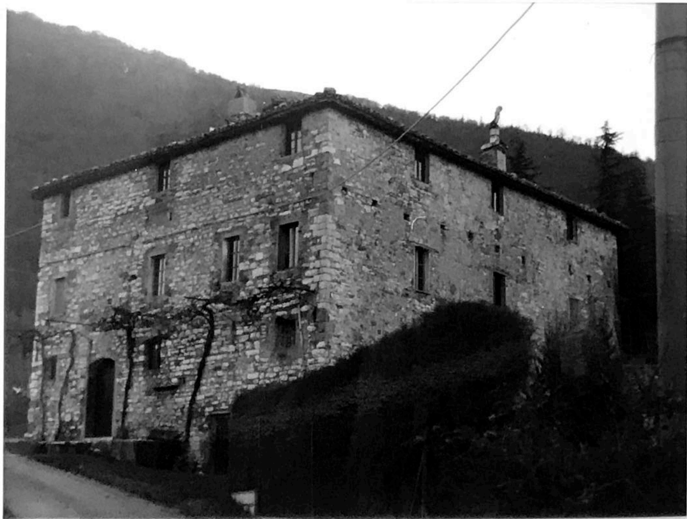
FOTO n°94 ingresso e lato nord-ovest
