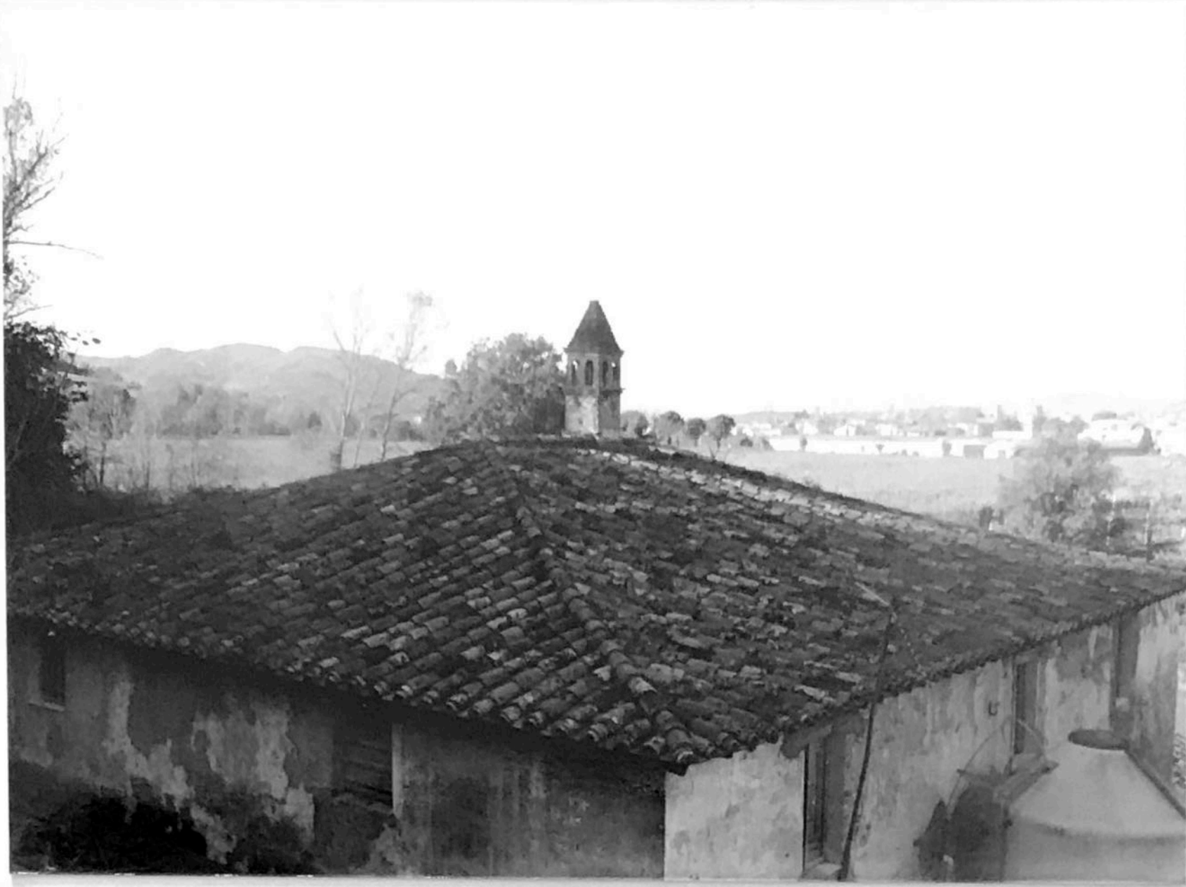
FOTO n° 87 VOC. MOLINO DI CASANOVA particolare del tetto
