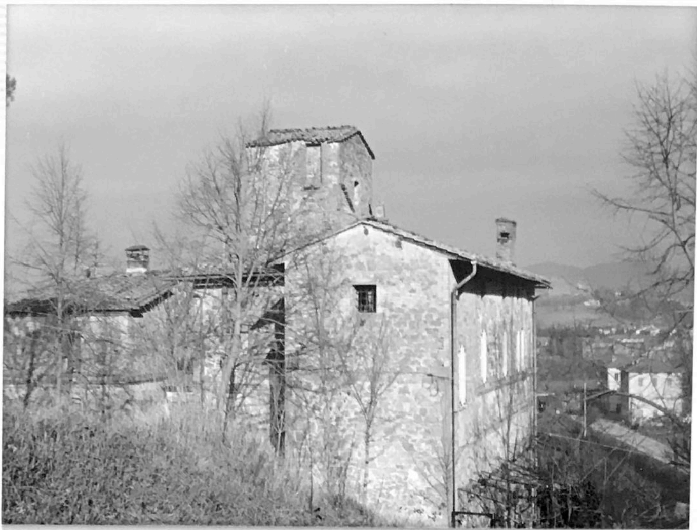
FOTO n°41 VOC.PIAGGIA DI METOLA veduta posteriore della torre
