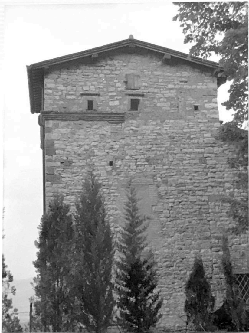
FOTO n°57 lato ovest della torre
