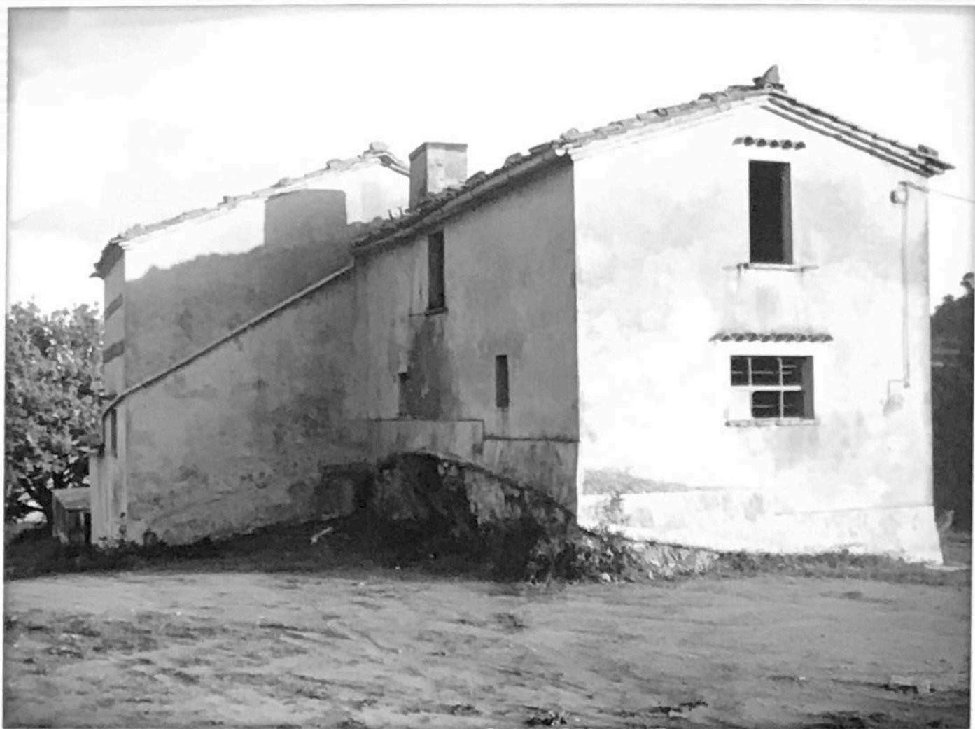
FOTO n°85 veduta del lato sud-ovest
