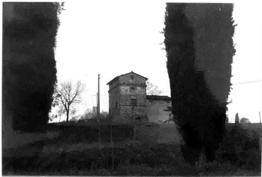
FOTO n°32 loc.Romeggio veduta di fron- te della torre
