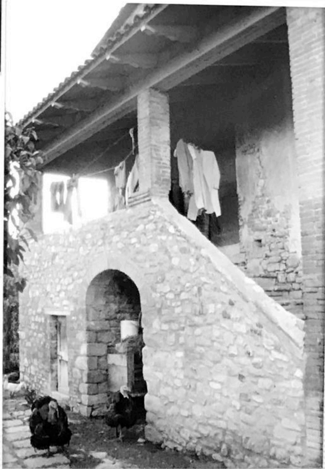
FOTO n°64 ingresso nel versante interno del cortile
