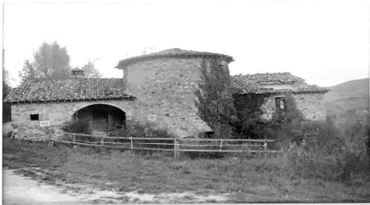
FOTO n°10 VOC.LA BUCA facciata
