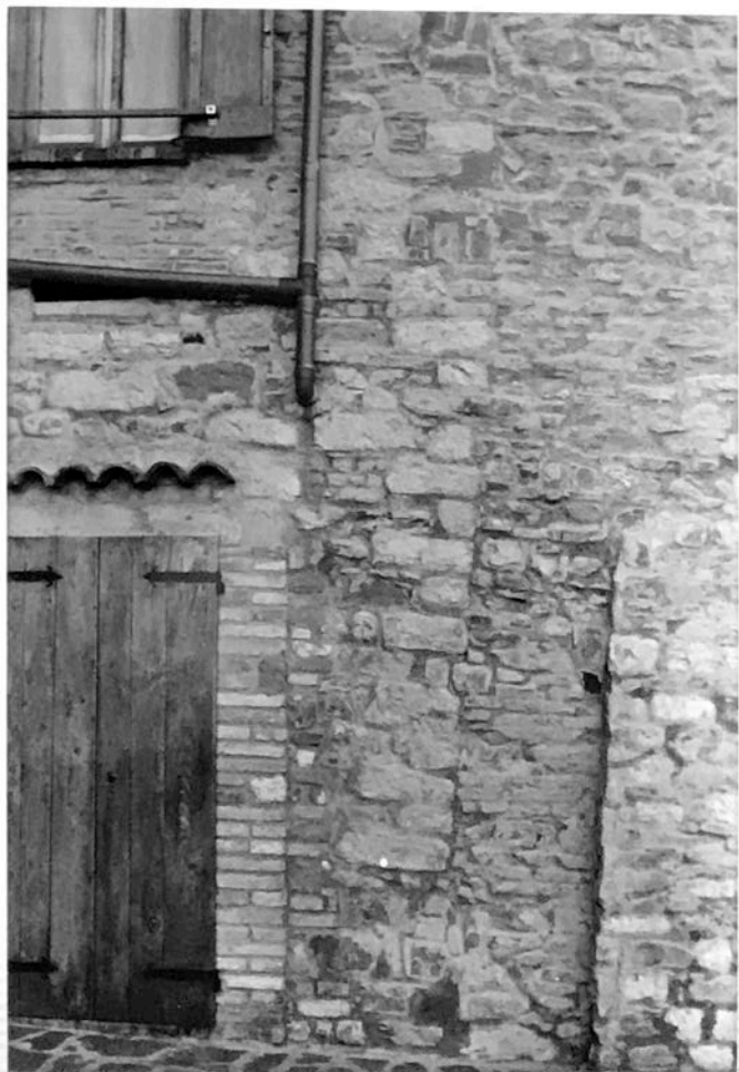
FOTO n°80 particolare del contrafforte che delimitava l'antica struttura
