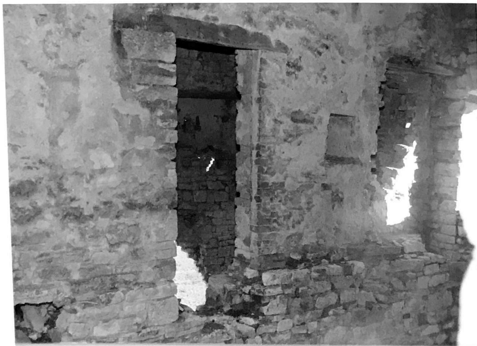
FOTO n°26 VOC.GALERA interno della torre
