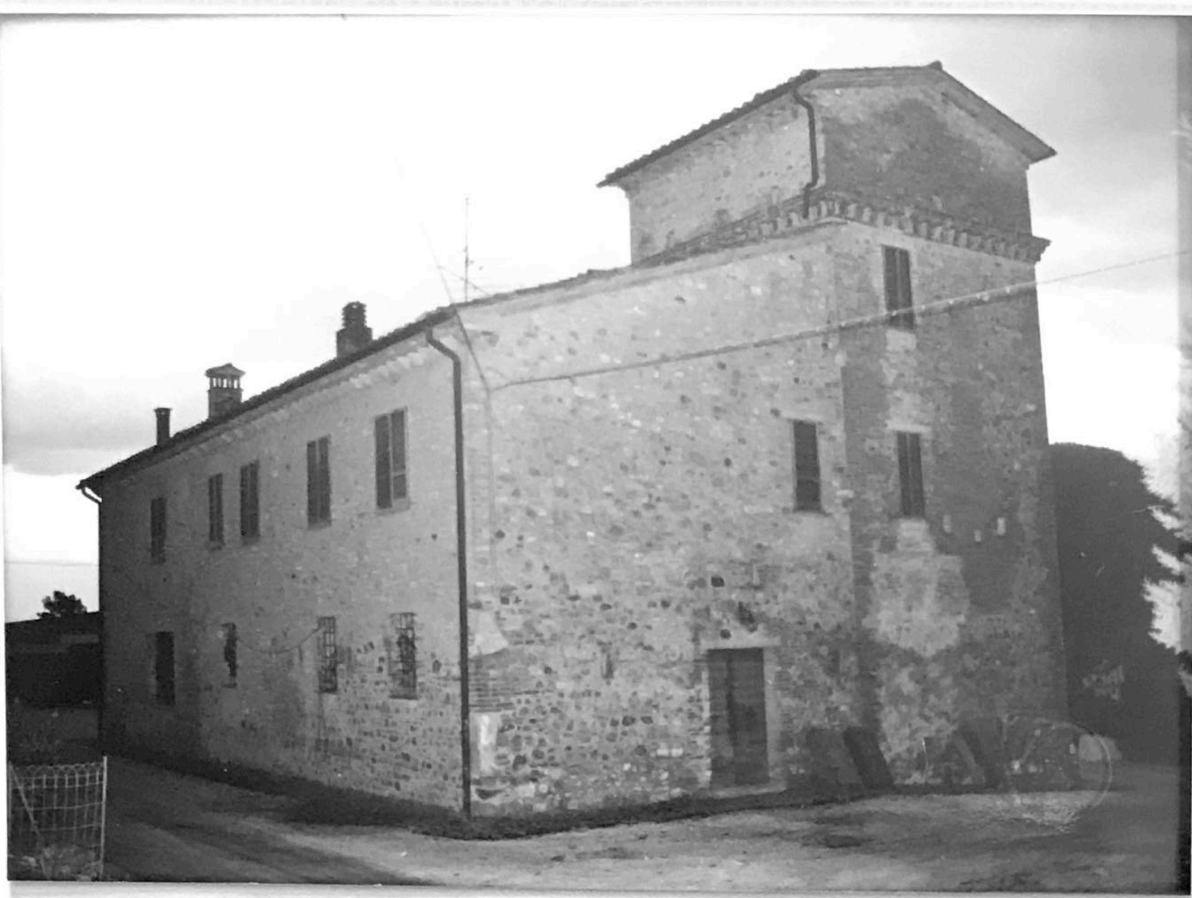
FOTO n°49 veduta del retro della casa e della torre
