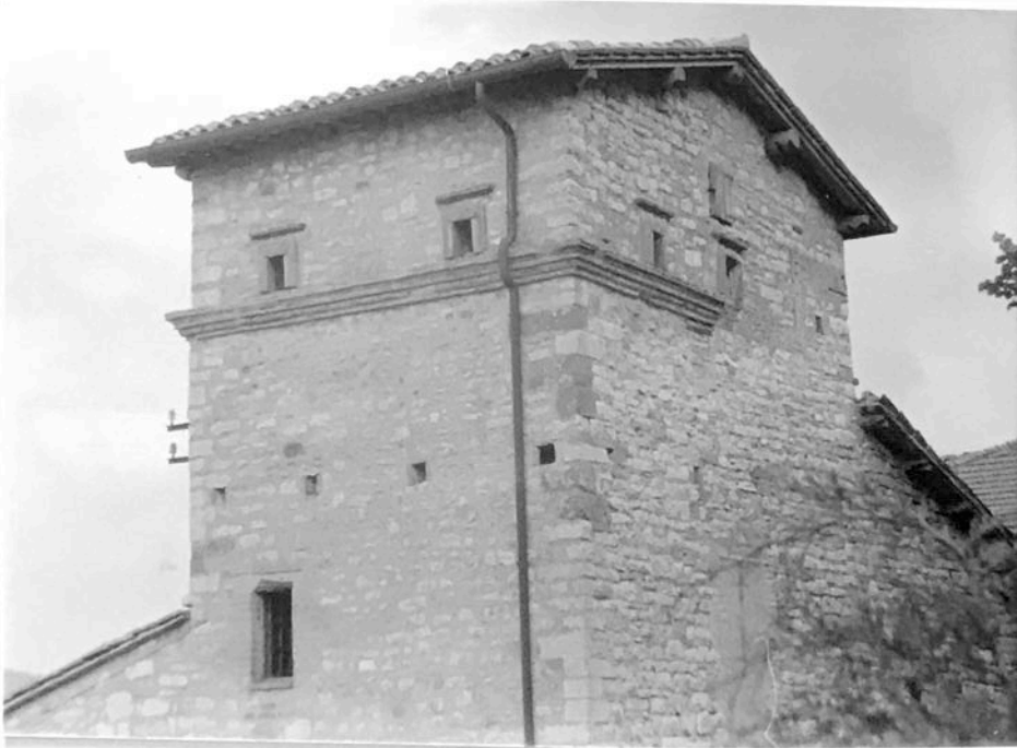
FOTO n°52 VOC.OSTERIA veduta lati ovest e nord
