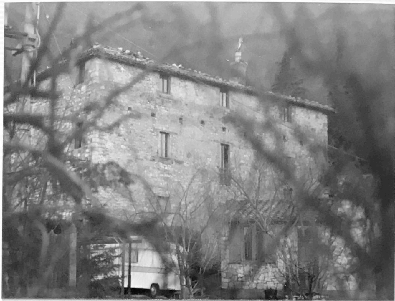
FOTO n°93 loc. Monte Acuto particolare dei fori per i colombi
