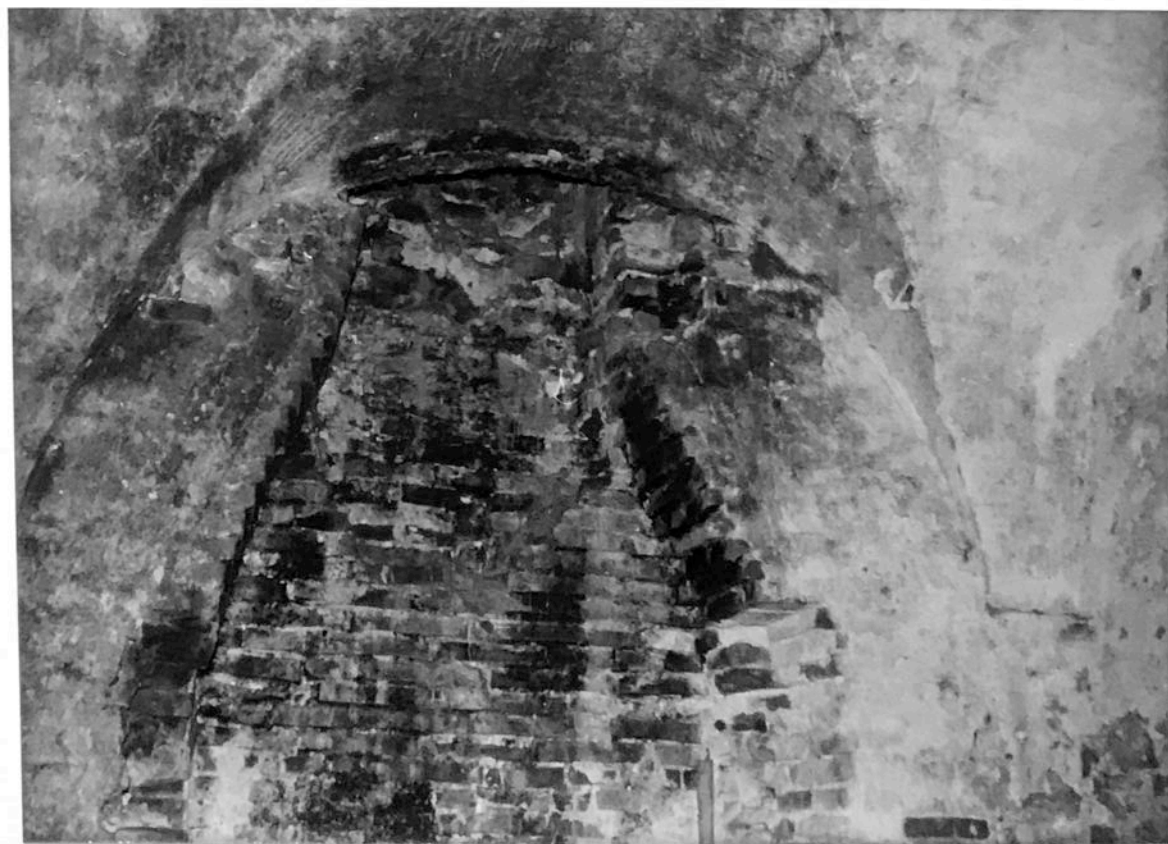
FOTO n°36 interno della torre, primo piano del camino
