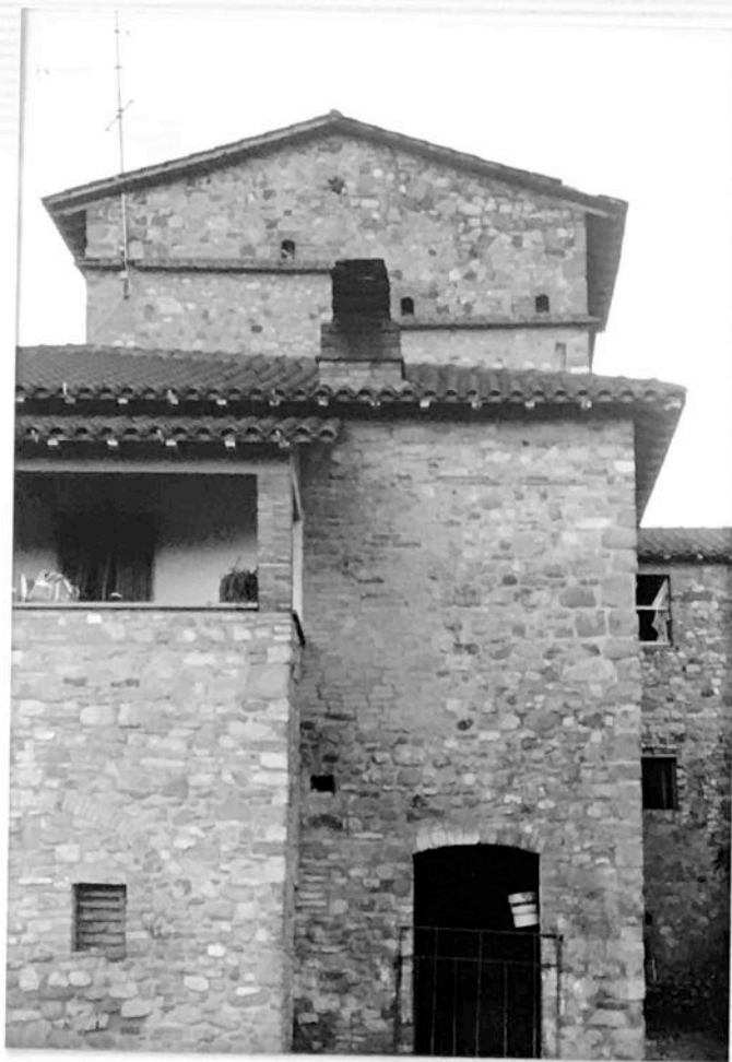
FOTO n°63 lato ovest della casa
