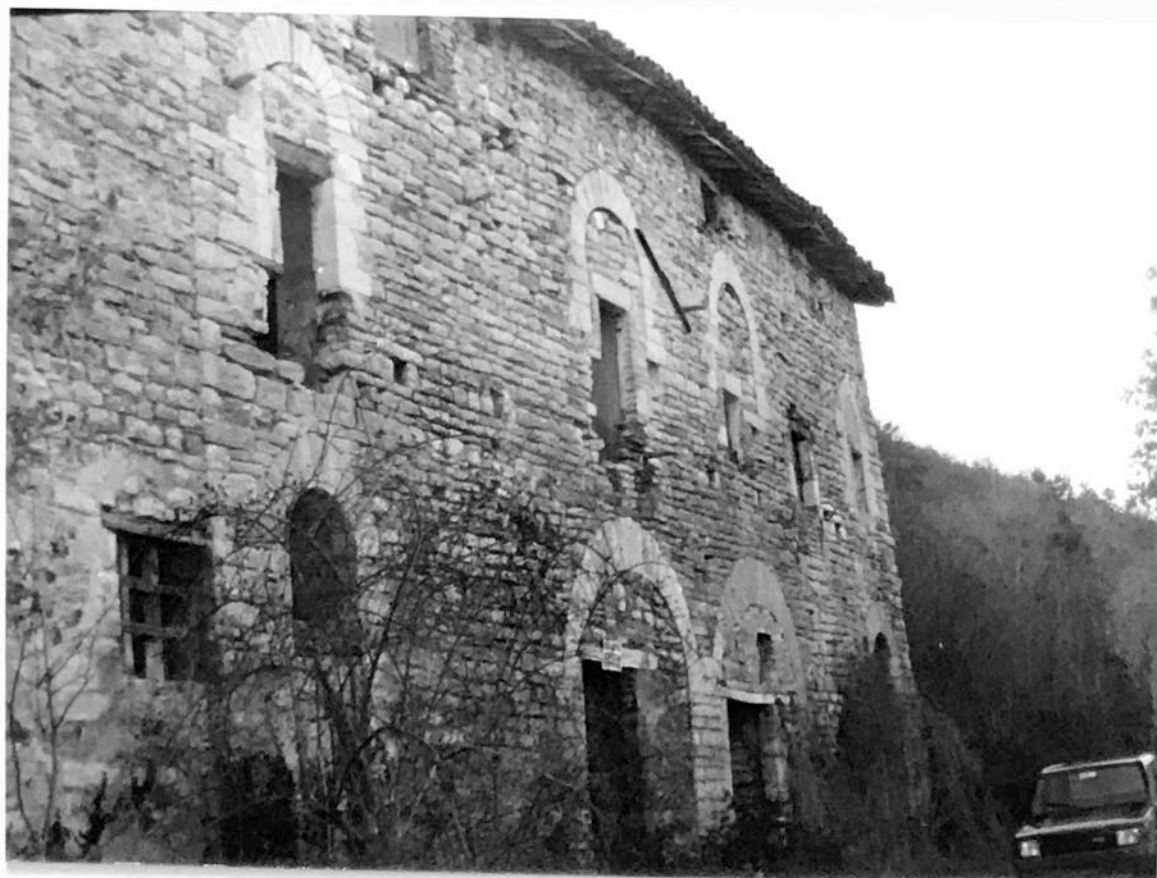
FOTO n°28 casa colonica in località Villa di Galera, lato posteriore
