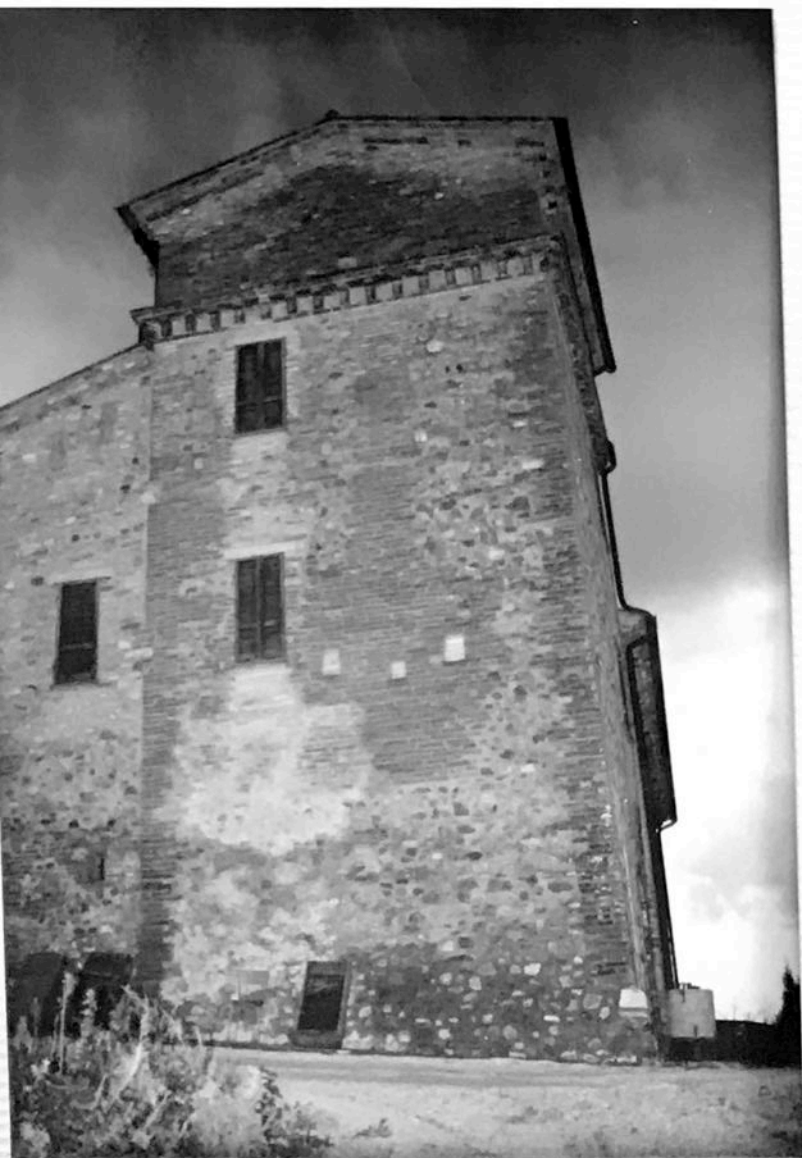
FOTO n°48 VOC.CENERELLE veduta della torre, lato nord
