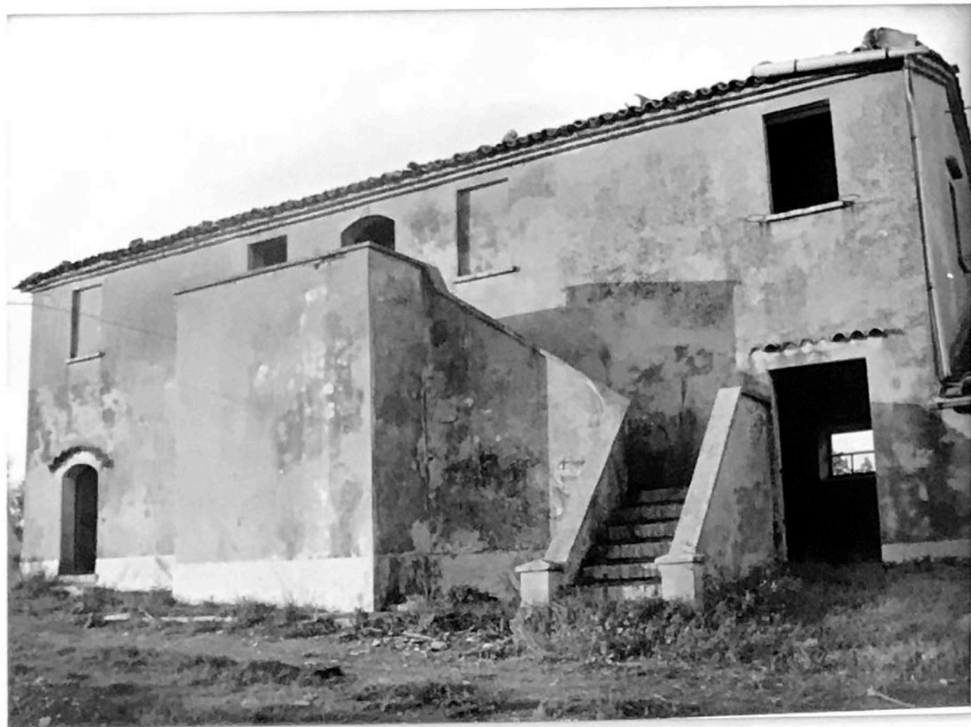
FOTO n°86 veduta dell'attuale ingresso nel lato ovest
