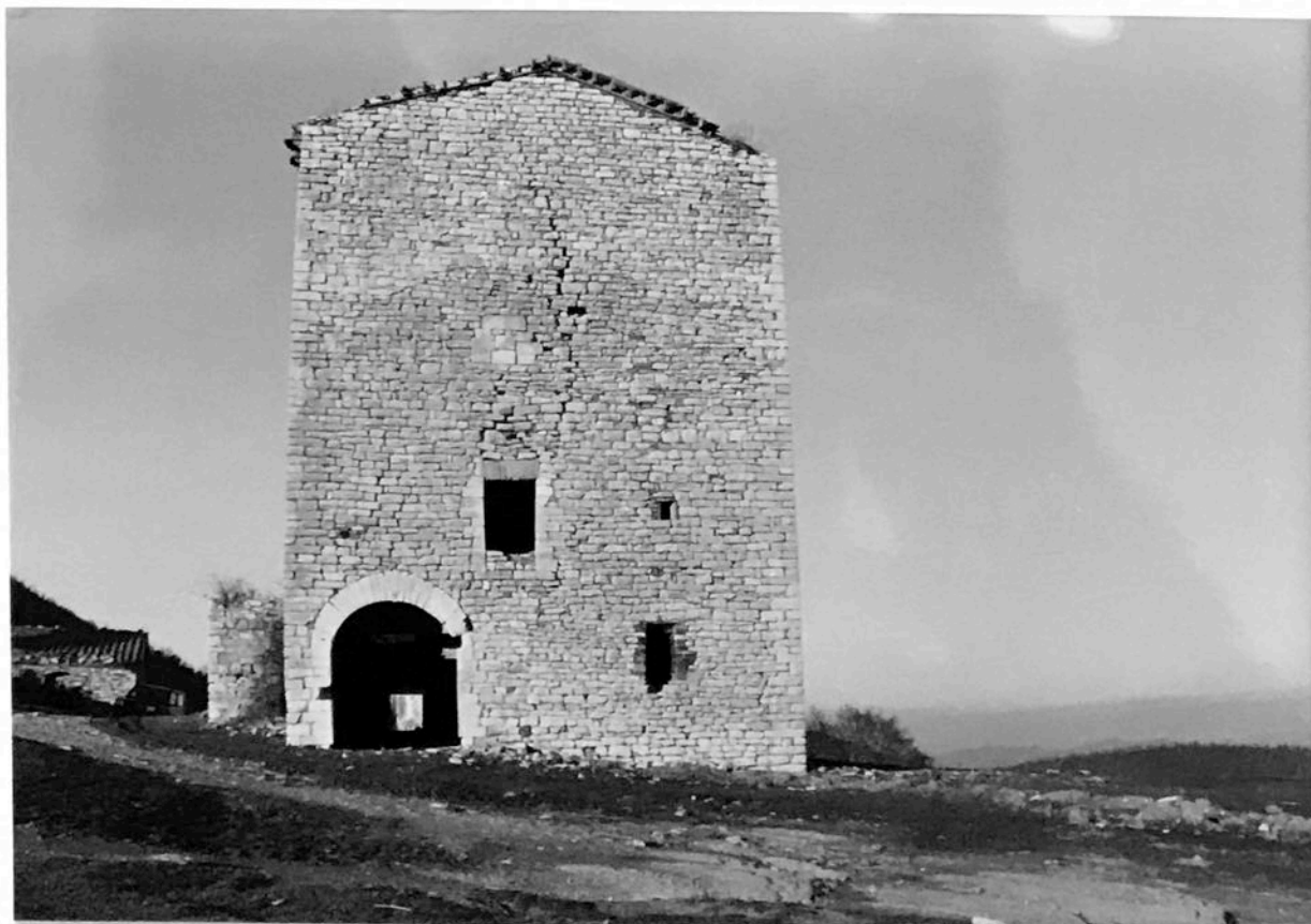
FOTO n°24 VOC.GALERA lato sud
